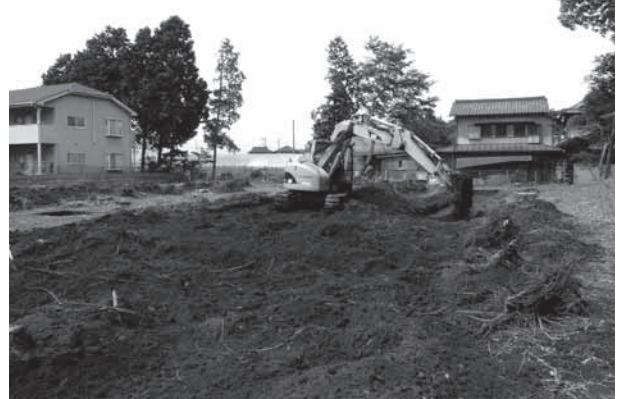
俣埜遺跡 L 地点 埋め戻し
