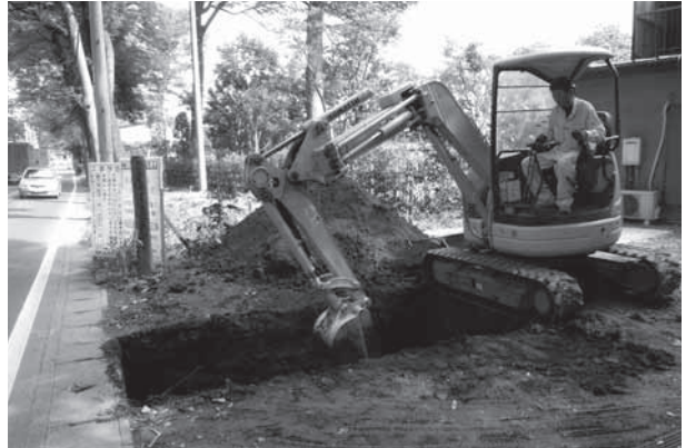
三富開拓地割遺跡第 12 地点 表土剥ぎ
