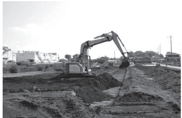
生出窪北遺跡第 3 地点 埋め戻し
