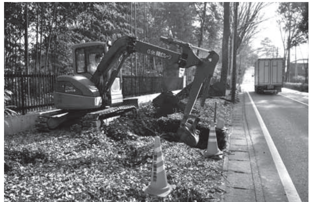
三富開拓地割遺跡第 13 地点 表土剥ぎ
