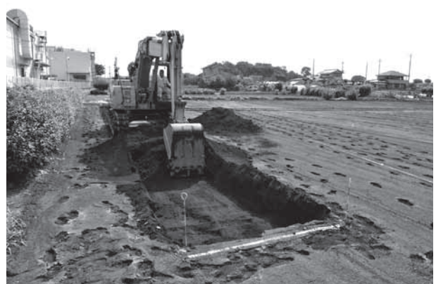
生出窪北遺跡第 3 地点 表土剥ぎ
