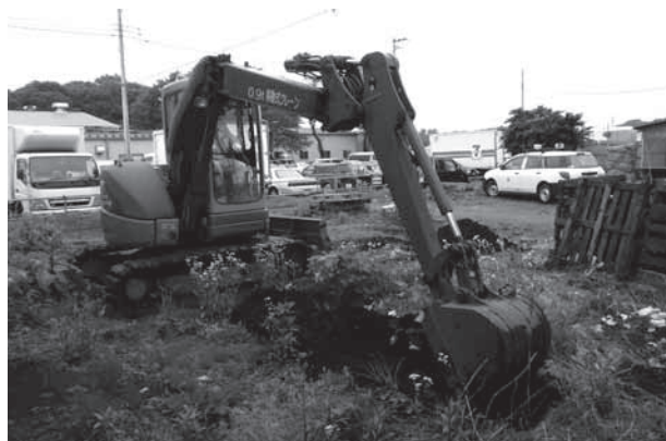
中東遺跡第 4 地点 表土剥ぎ
