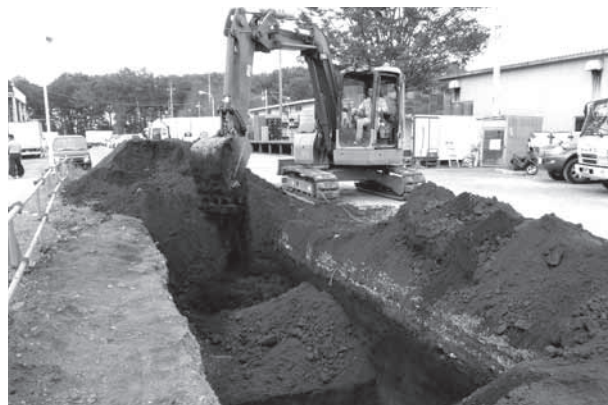
中東遺跡第 5 地点 埋め戻し
