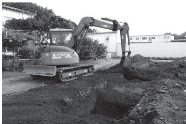
中東遺跡第 4 地点 埋め戻し
