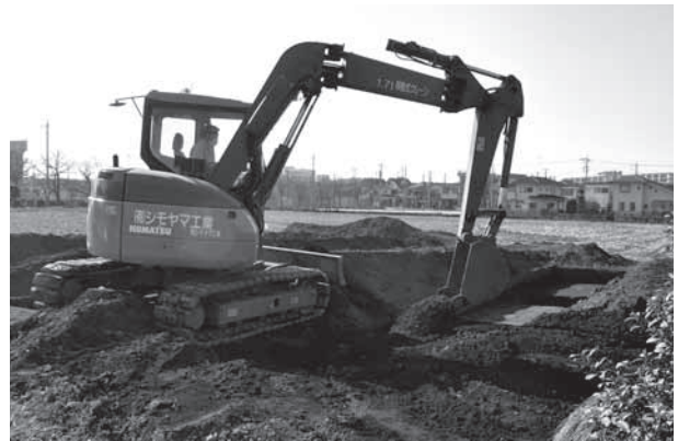
北原遺跡第 8 地点 埋め戻し
