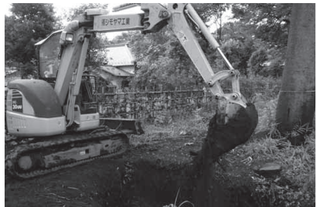
三富開拓地割遺跡第 10・第 11 地点 埋め戻し
