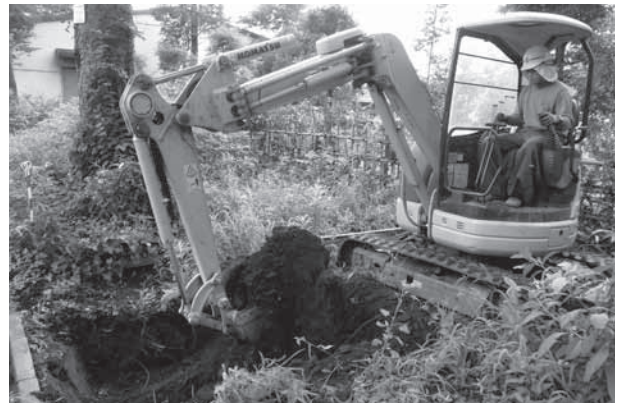
三富開拓地割遺跡第 10・第 11 地点 表土剥ぎ
