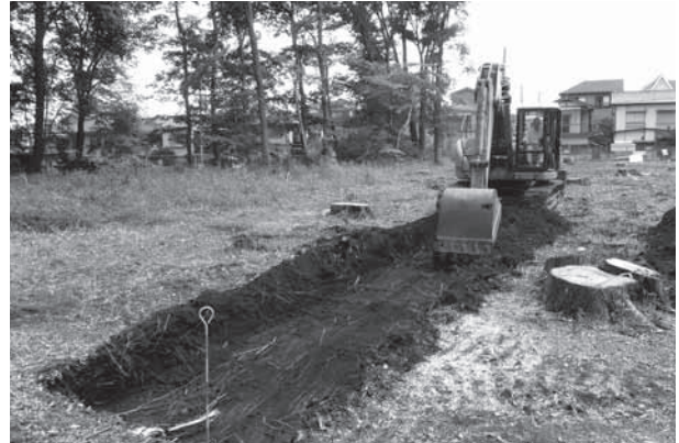
俣埜遺跡 L 地点 表土剥ぎ
