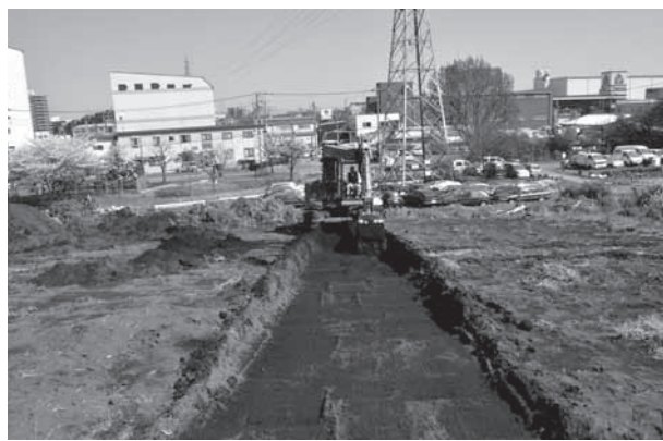
本村北遺跡 G 地点 表土剥ぎ
