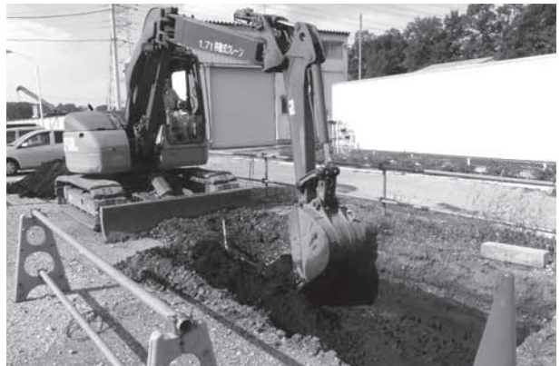
中東遺跡第 5 地点 表土剥ぎ
