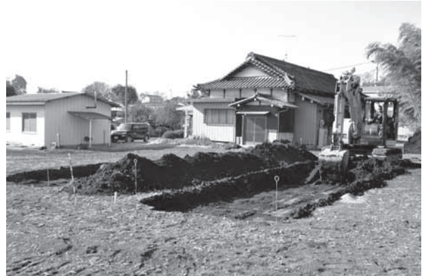
本村北遺跡 F 地点 表土剥ぎ
