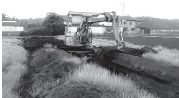
上永久保遺跡第 2 地点（2 次）埋め戻し
