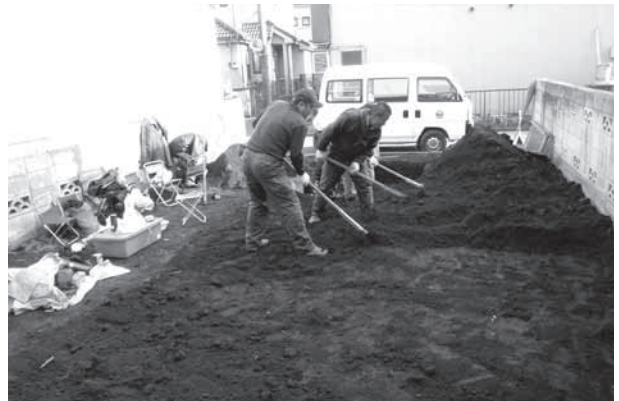
浅間後遺跡 (近接地) 埋め戻し
