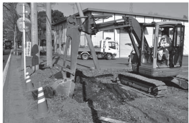
三富開拓地割遺跡第 14 地点 表土剥ぎ
