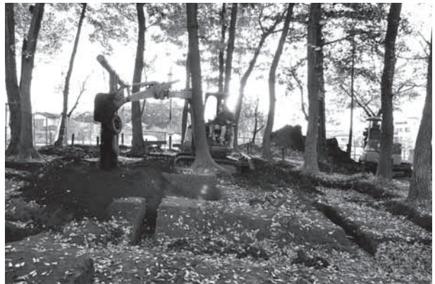
俣埜遺跡 O 地点 埋め戻し
