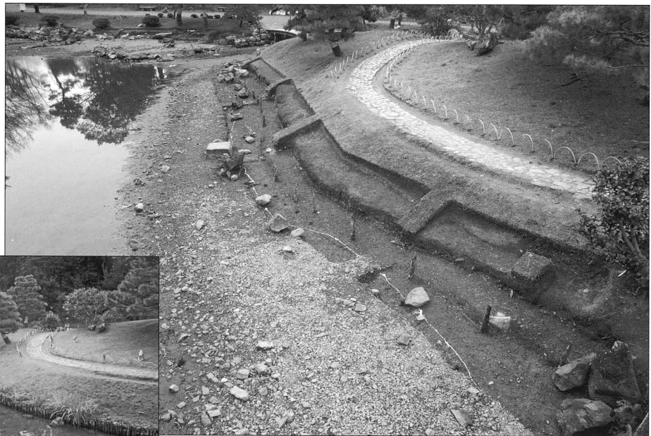
蘇鉄山東側の石組み護岸跡と乱杭検出状況（白線は基盤面）
