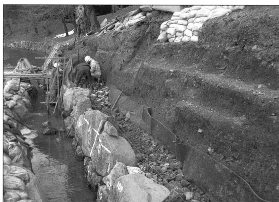
石垣の積み直し
