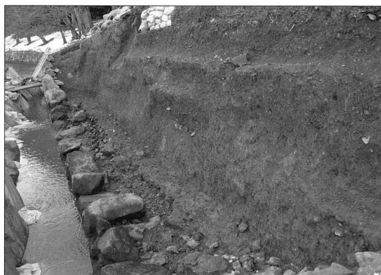
裏込石の検出状況
