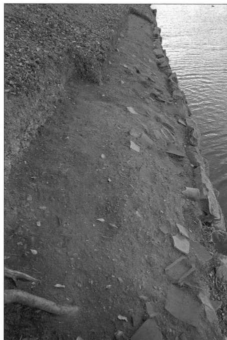
天端石の内側で検出した瓦溜り
