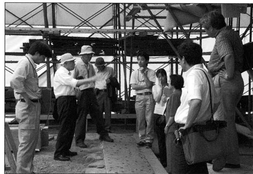
楽々園御書院解体修理工事の現地指導
