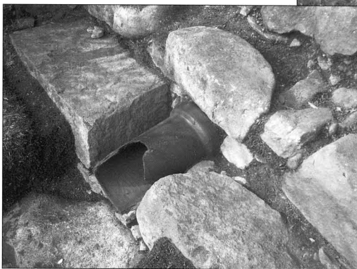
水門外側の陶製排水管
