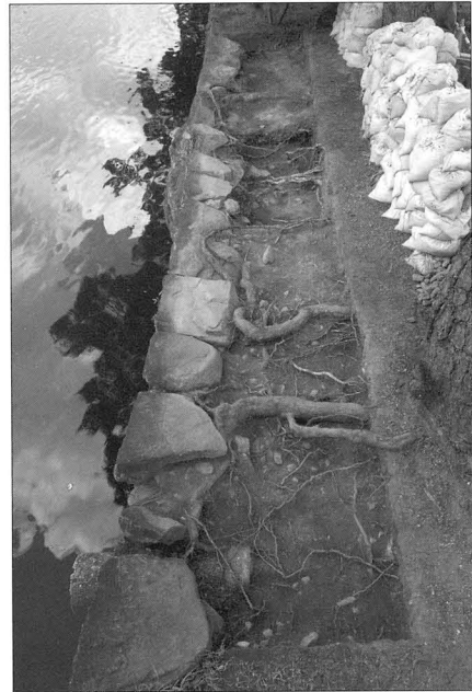
石垣天端の発掘調査
