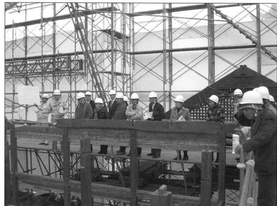
復元工事の説明を聞く見学者
