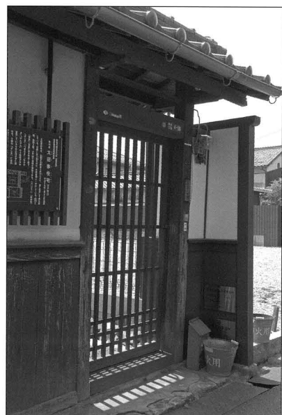
太田家住宅の保存修理箇所
