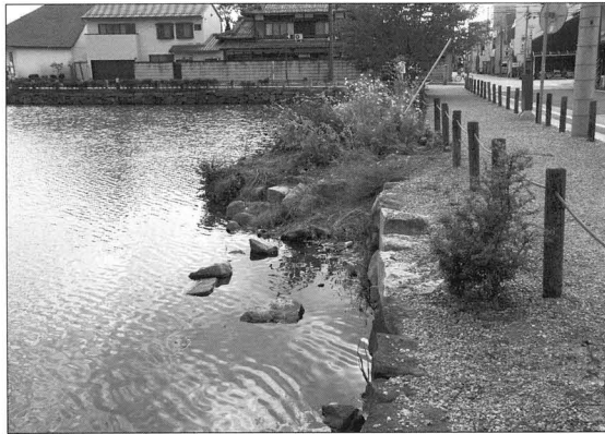
調査前の石垣の状況
