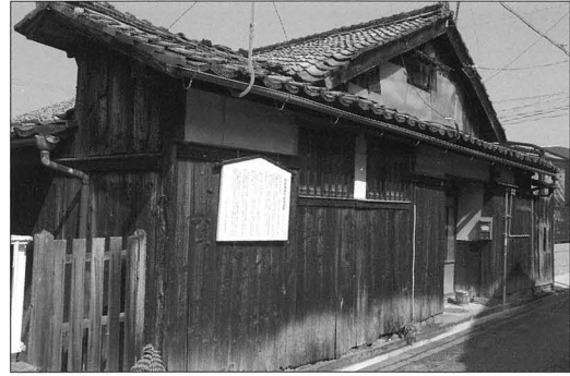
彦根藩足軽組屋敷（善利組・吉居家住宅）
