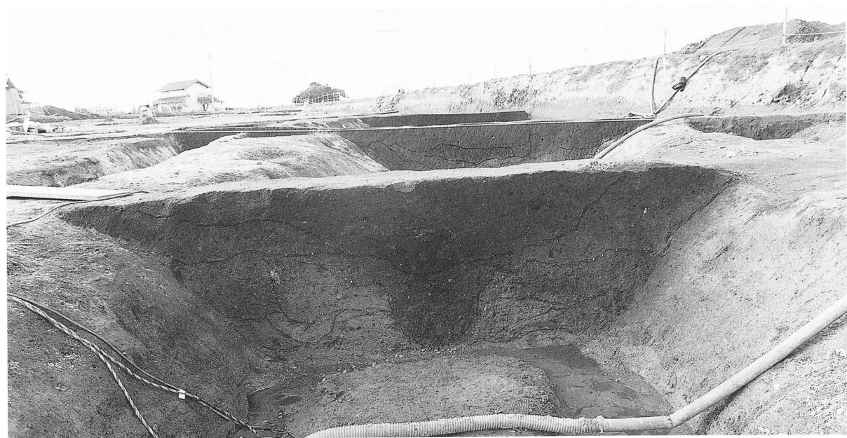
Fig.100 SD39 土層断面写真（上からFig.98のA、B、Cライン）
