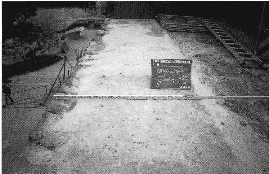
石垣修理工事竣工 (A面)
