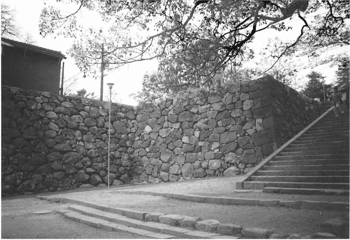
竣工石垣（B面）
