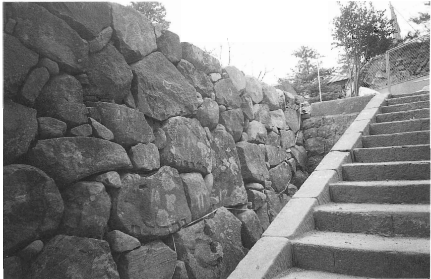
修理工事竣工（C面）
