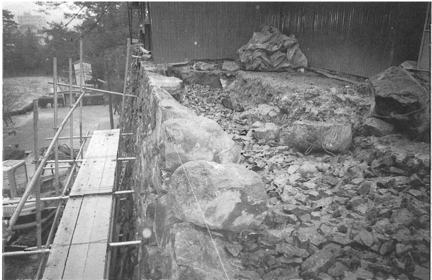
石垣修理工事中石積み中 (A面)
