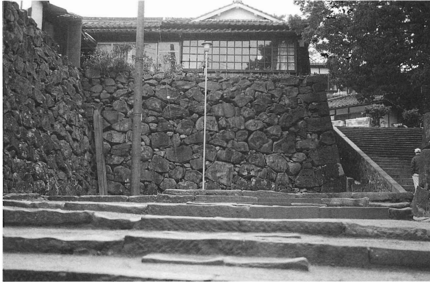
石垣修理前（A・B面）全景（崩壊前）
