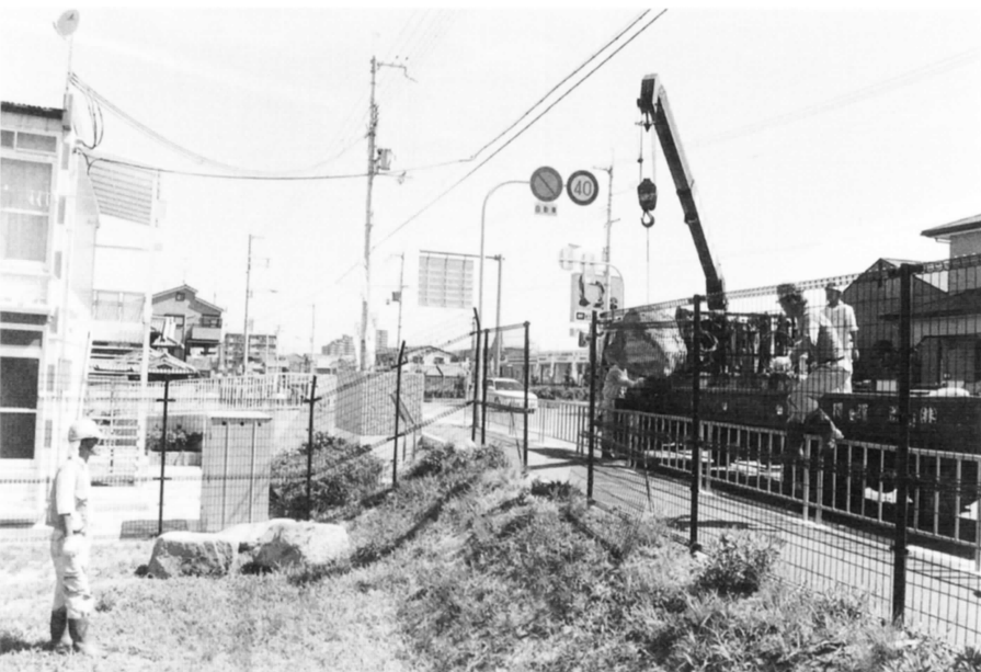
3. 礎石移設作業
