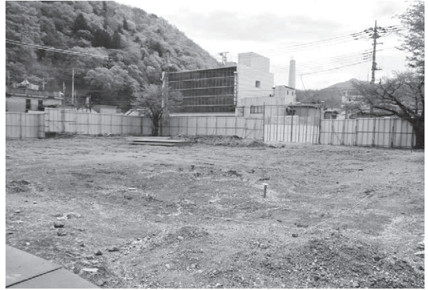
調査着手前状況 (H27)
