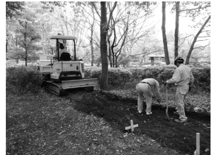
重機による剥ぎ取り
