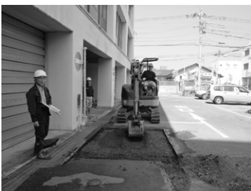
G 4 地点の掘削
