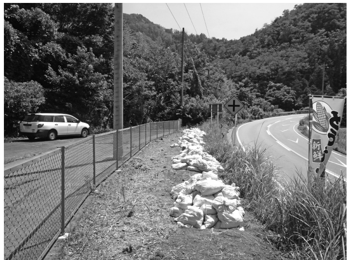
埋め戻し完了・調査終了
