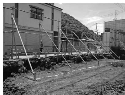
調査現場状況
