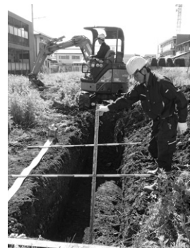
G トレンチの掘削
