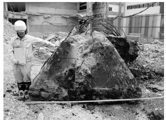
撤去したフーチング基礎
