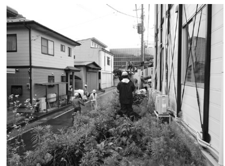
調査現場状況—地点2北から
