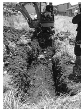
B トレンチの掘削
