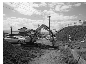
G地点の掘削
