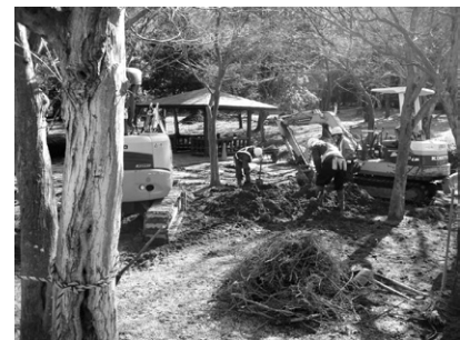
1 月 27 日抜根後の埋め戻し風景
