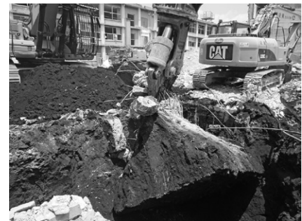
フーチング基礎の取上開始
