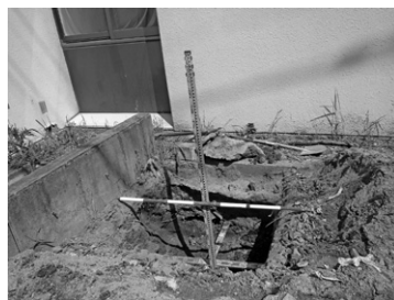
B 9 地点の掘り上がり
