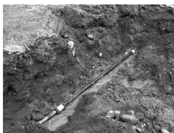
水道管の修理完了
