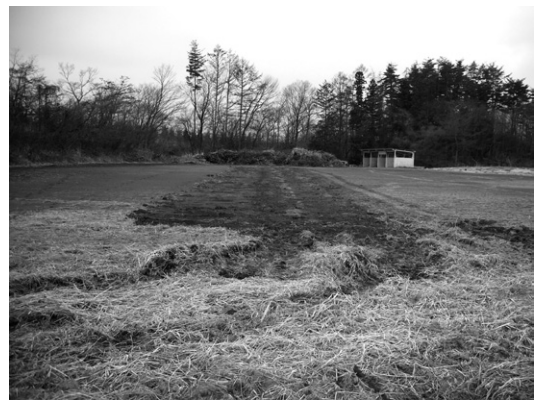
5 T埋め戻し状況
