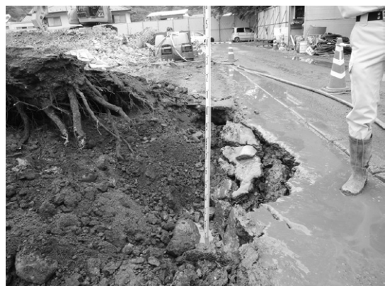
抜根実施跡（南側）
