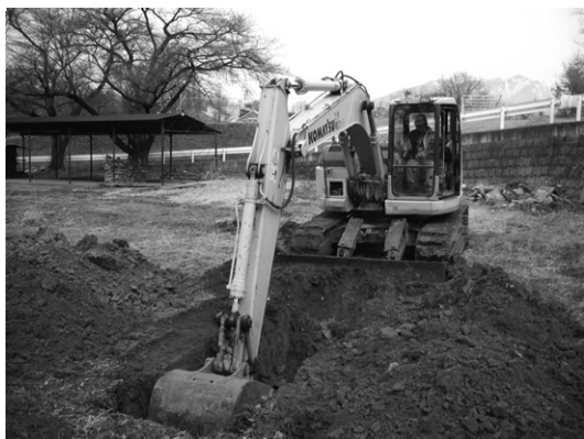
第1トレンチ掘削状況
