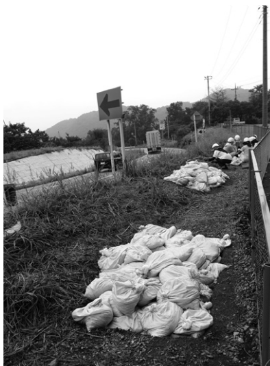
土嚢袋の埋め戻し
