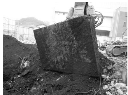
撤去された基礎
