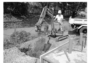
調査現場状況
