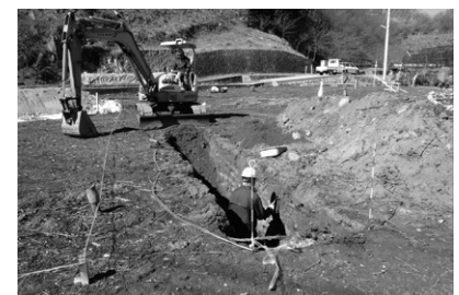
1号トレンチ土層観察作業
