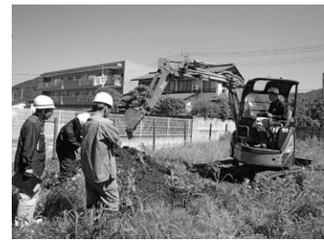
A トレンチの掘削
