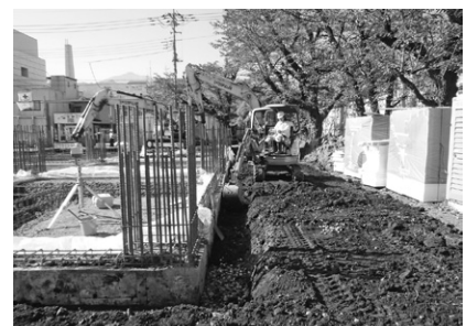
立会調査前（給水管から南方向）
