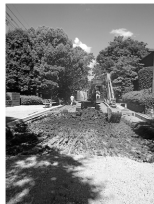
剥ぎ取り作業
