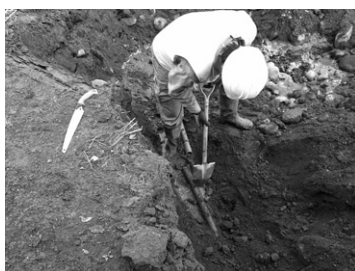
水道管の修復作業
