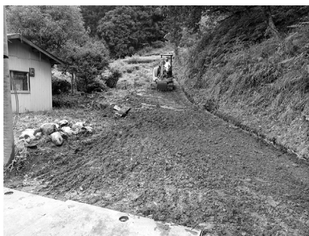
進入路工事後の状況
