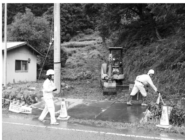
進入路工事前の状況
