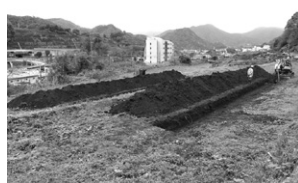
A B トレンチ（西から）
