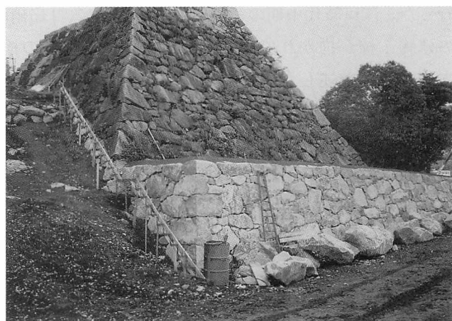
図23 鉄門東腰石垣施工後
