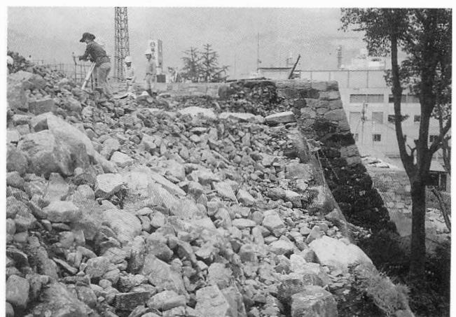
図11 本丸北腰石垣解体状況
