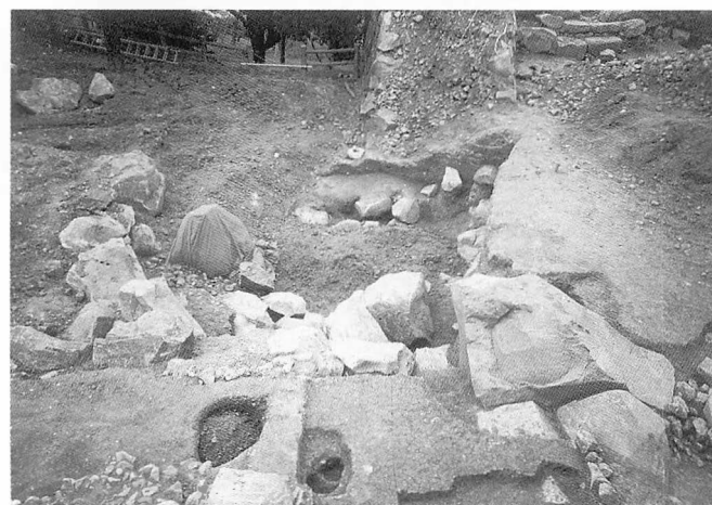
勝手門・数寄屋曲輪調査状況
