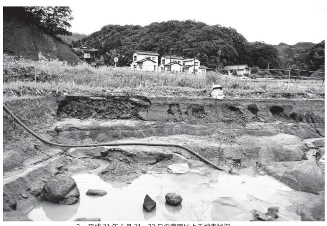
2. 平成21年6月21・22日の豪雨による被害状況調査区南東の壁面が側面からの出水のため崩壊
