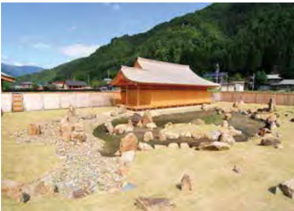
写真 8 州浜護岸と石組み護岸を併用する事例 （江馬氏館跡庭園） 飛騨市教育委員会 提供
