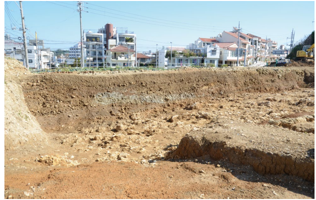
③Ⅲ区の堆積状況
