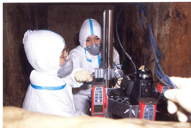
Fig. 15 機材のセッティング
