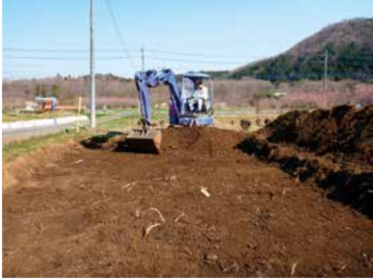
大福寺境内遺跡 重機稼働状況
