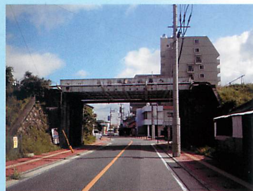
専用鉄道敷跡 高架橋
