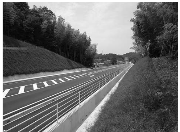
南部バイパス（境内海道西遺跡現況）
