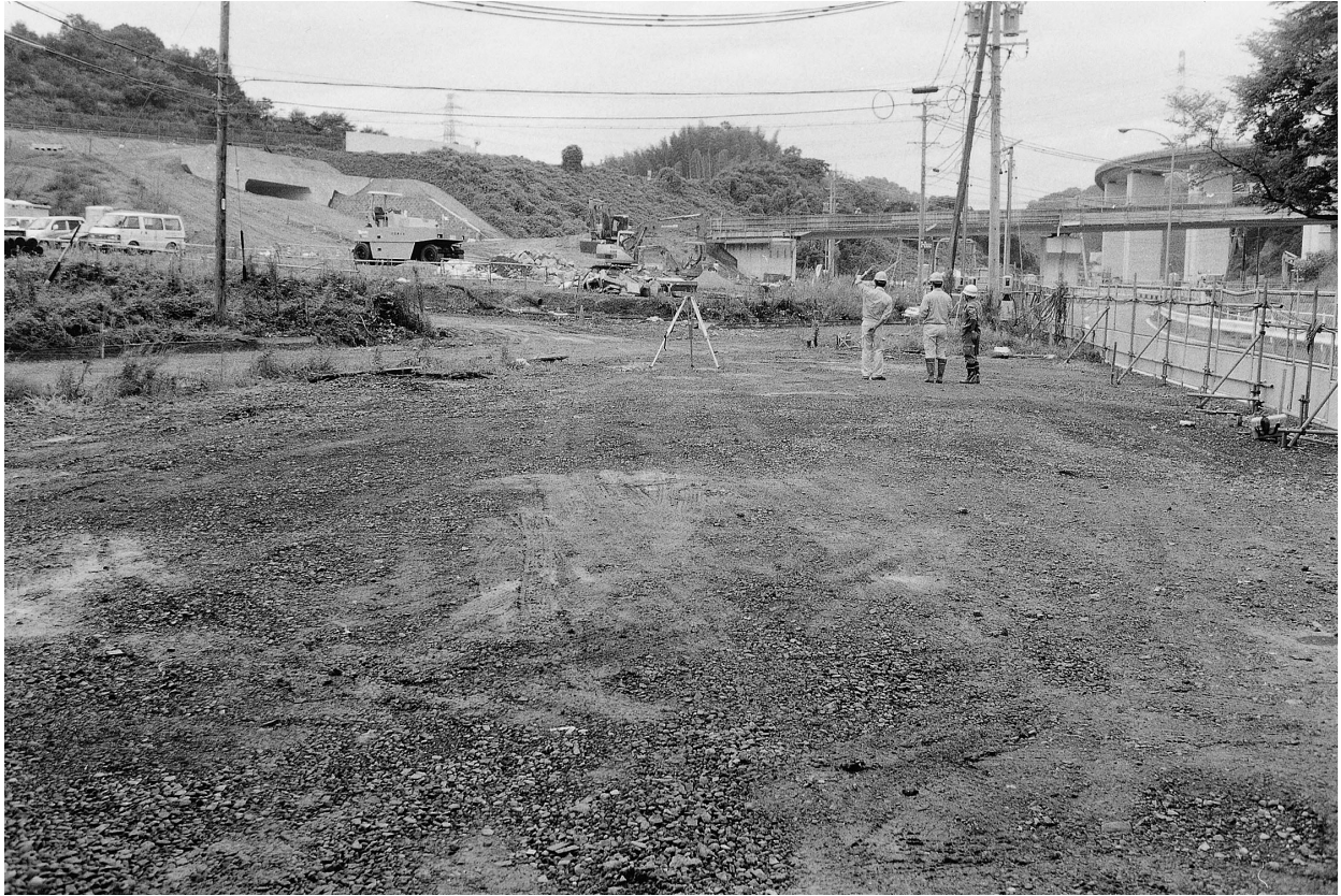
平成14年度調査区調査前風景（南から）
