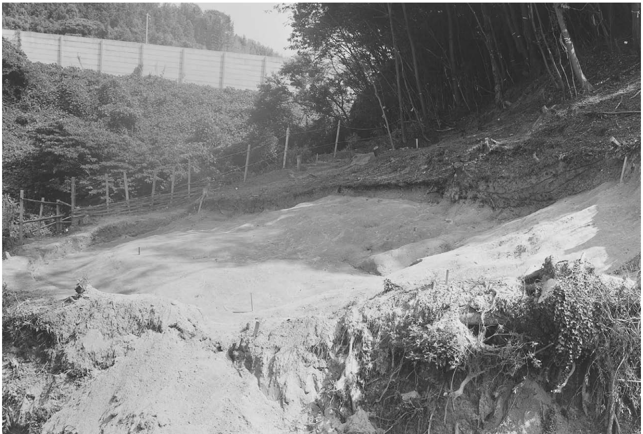
写真 40 北地区②調査後（北西から）
