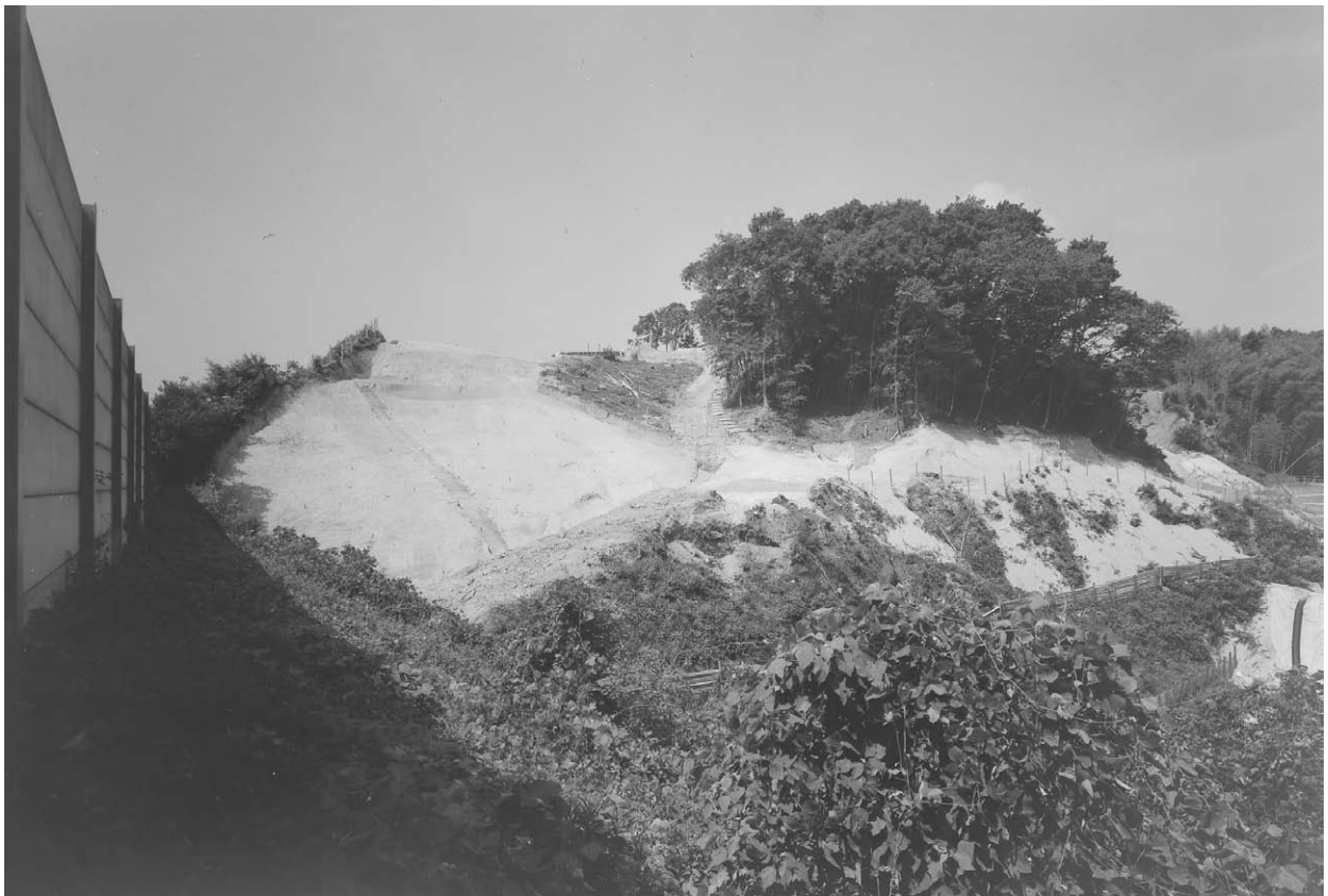
写真 51 西地区①東斜面調査後（東から）
