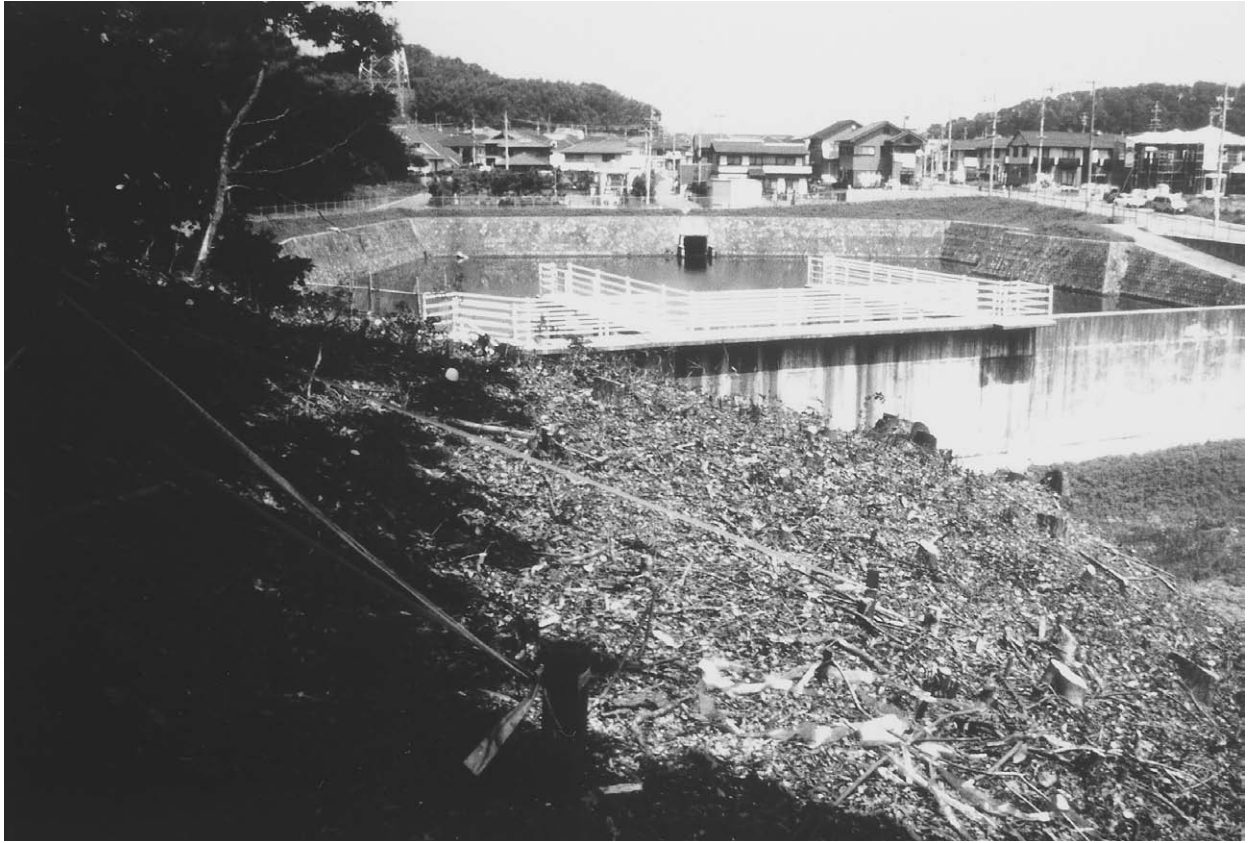
写真 39 北地区②調査前（南から）
