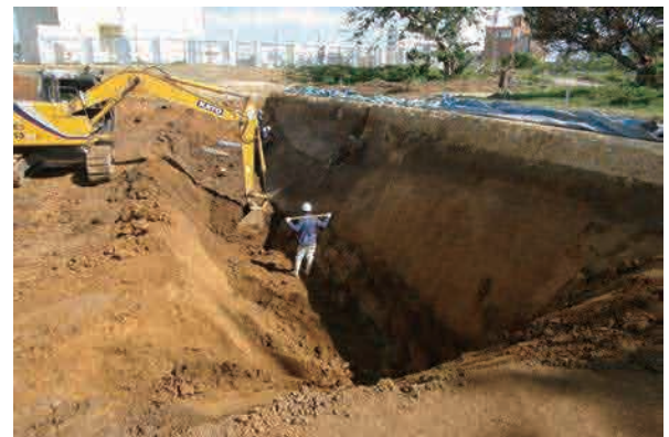
確認トレンチ掘削作業 (XI 地区)
