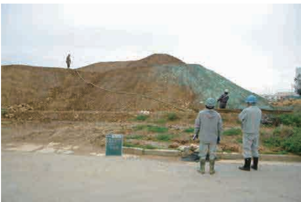
侵食防止剤吹付け作業 (平成 24 年度) 図版 2 発掘調査・資料整理状況 2
