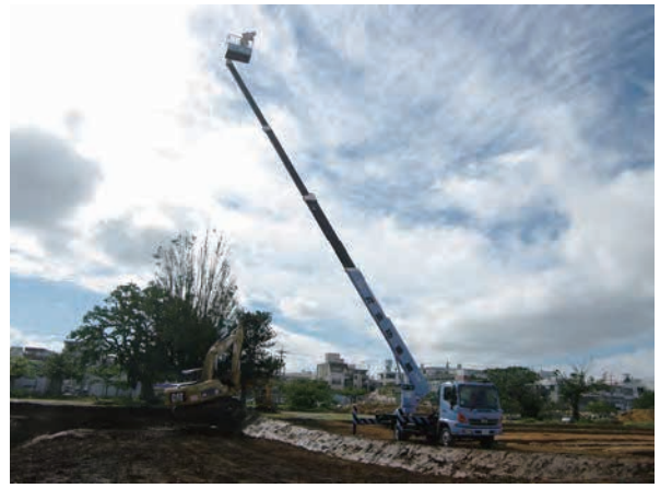
高所作業車による撮影 (XI 地区)
