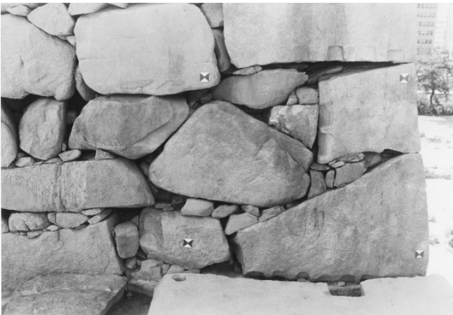
入口 ホゾ穴・R面鑄検出状況 (北から)
