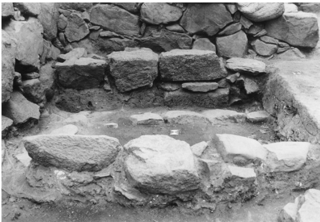
本丸 南多聞櫓台前面の水路遺構（北から）
