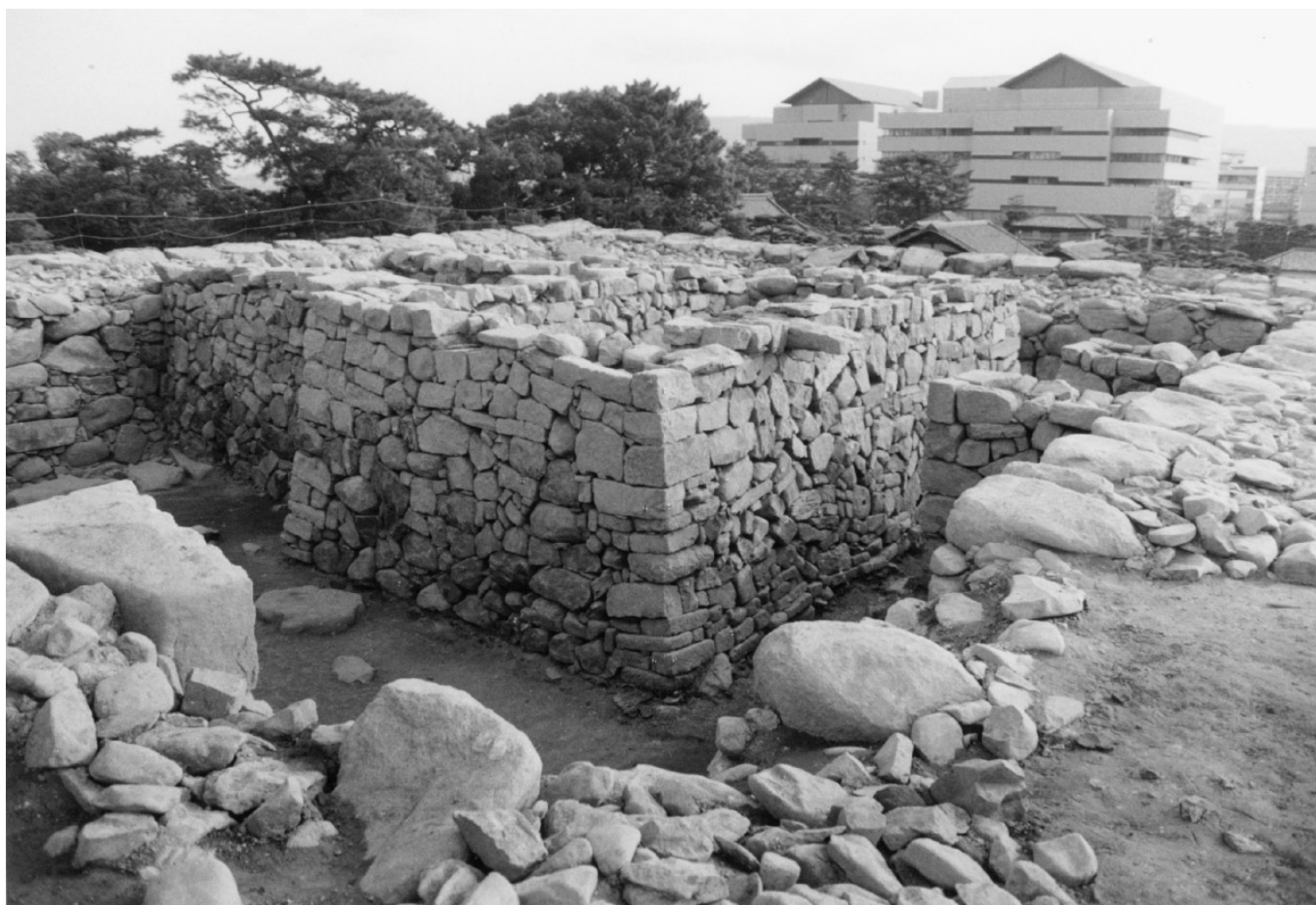
玉藻廟基礎 完掘状況（南西から）
