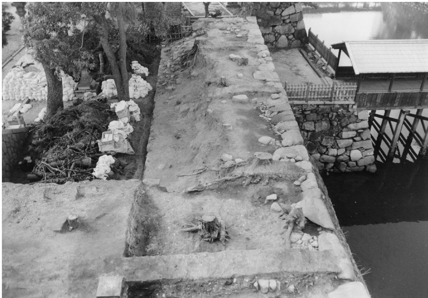
中川槽台 完掘状況（東から）
