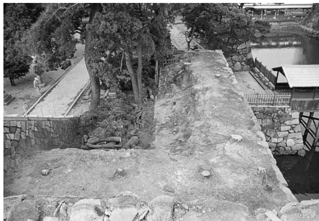
天守台前面 中川櫓台 調査以前 (東から)
