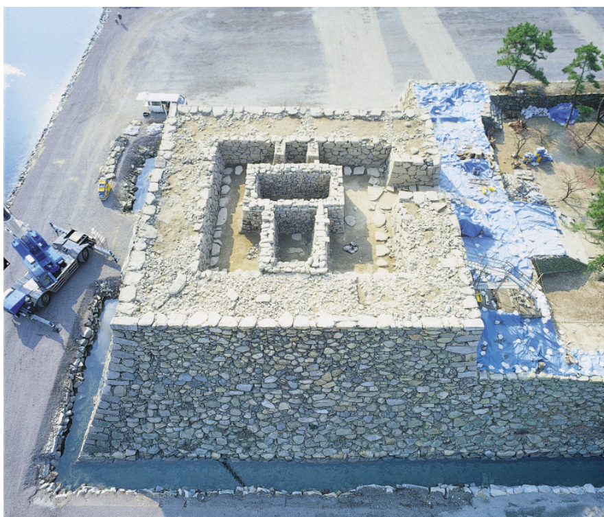
玉藻廟基礎 完掘状況（北から）
