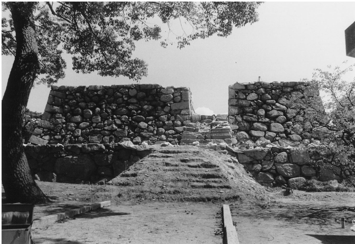
玉藻廟階段撤去（西から）
