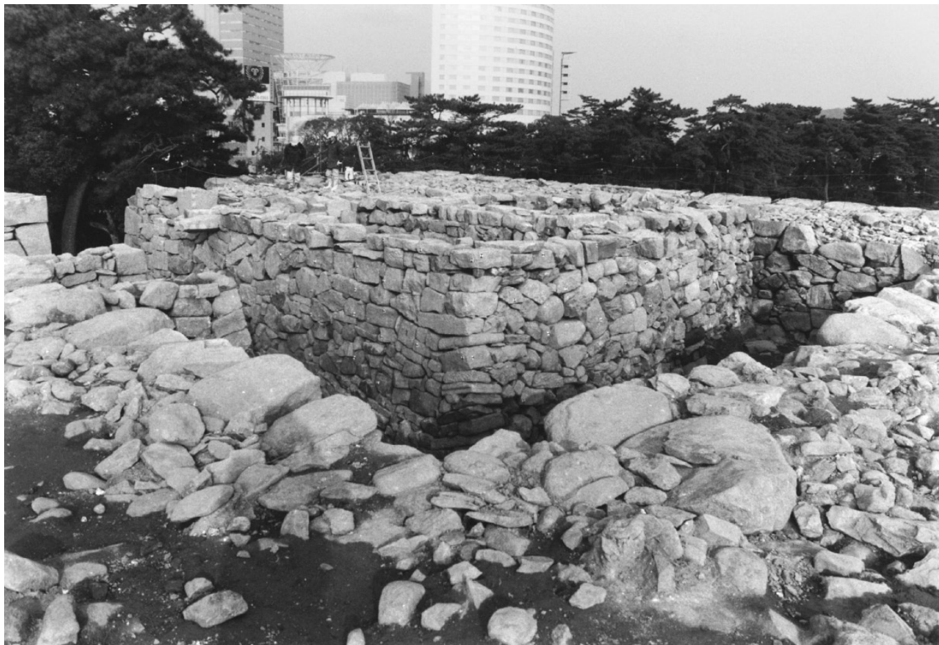
玉藻廟基礎 完掘状況（南東から）
