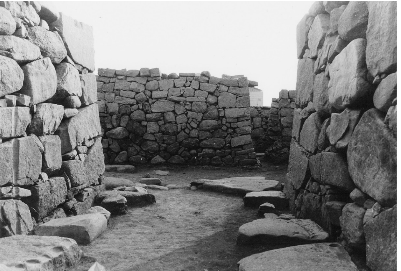
玉藻廟基礎 (天守地下1階の入口から)
