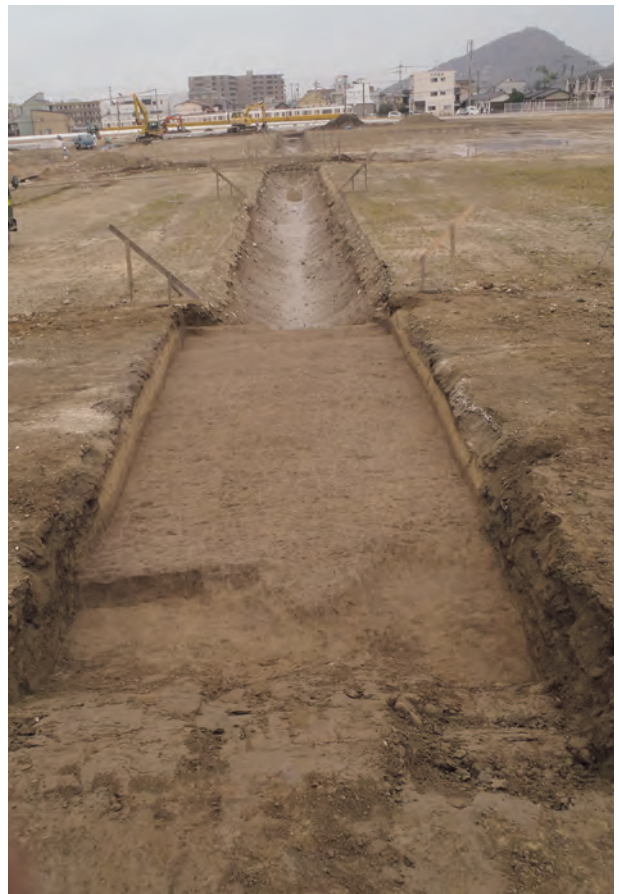
第 47 調査区 全景（西から）
