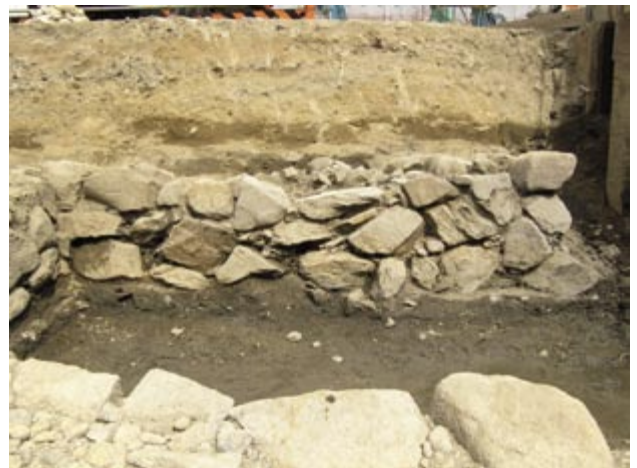
4 A工区南側 石垣2 石積みの状況 (西から)
