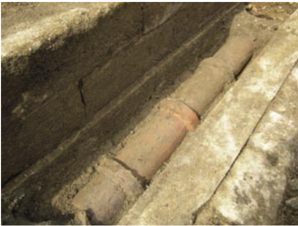
1 立会調査 導水路B-2 土管 設置状況 (南東から)
