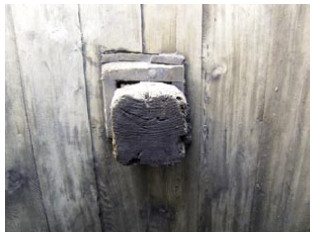
5 B工区 井戸1内部の状況 (西から)
