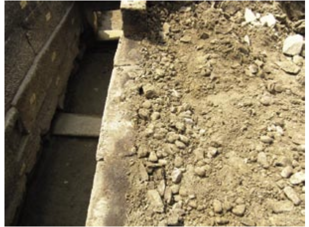
4 A工区 導水路A 背部構造 (南から)
