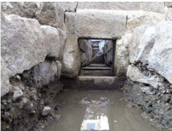
4 A工区 配石遺構内部からの導水路A (南から)
