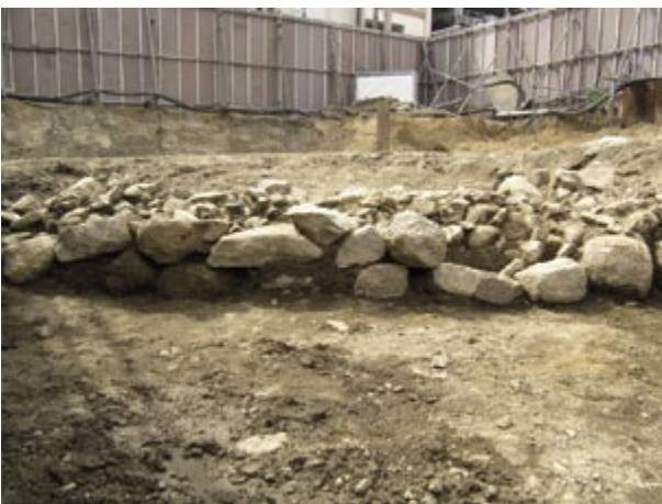
4 A工区 石垣4 石積み状況 (南東から)
