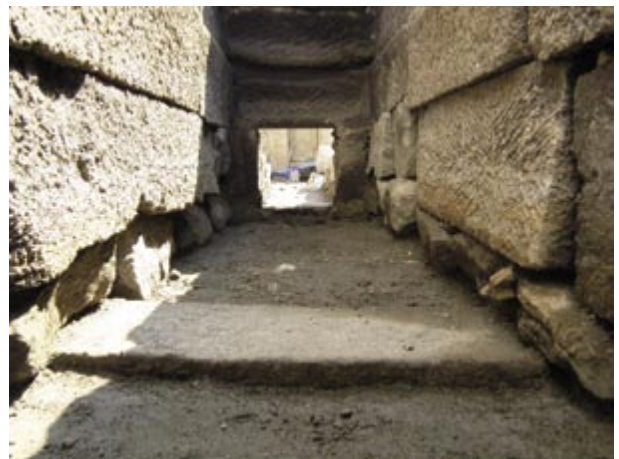
5 A工区 導水路A 基底部の状況 (南から)
