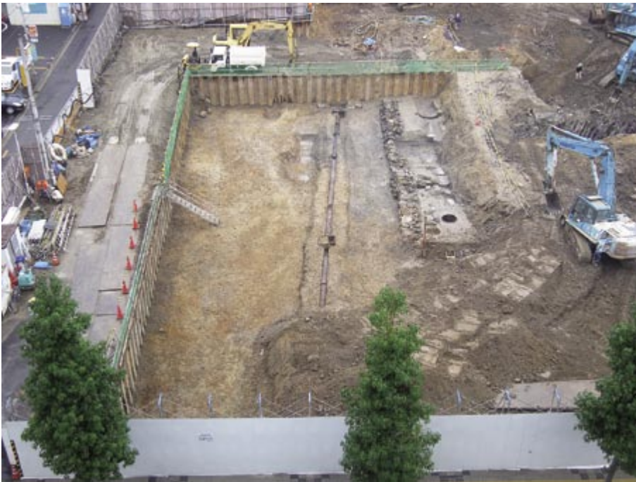
2 B工区 全景（南から）
