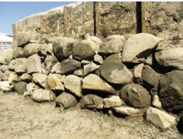
3 B工区南側 石垣2 石積みの状況 (南西から)
