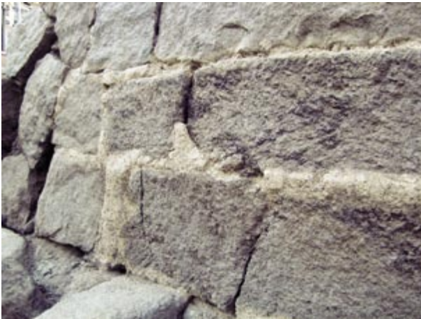
3 A工区 導水路A 貯水部露出面の石材 (南東から)
