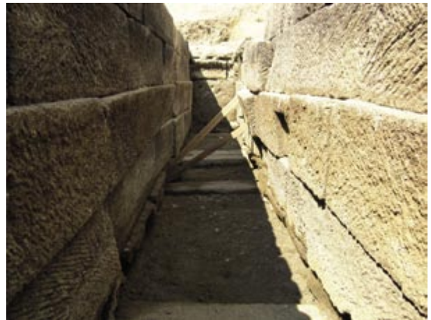
3 A工区 導水路A北半 内部 (南から)
