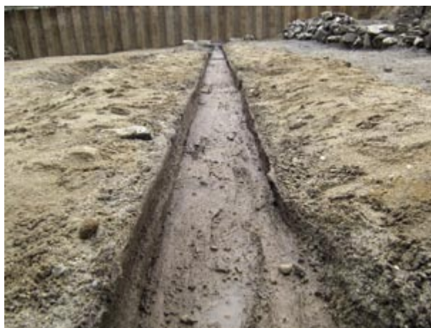
2 B工区 木樋 設置状況 (南から)
