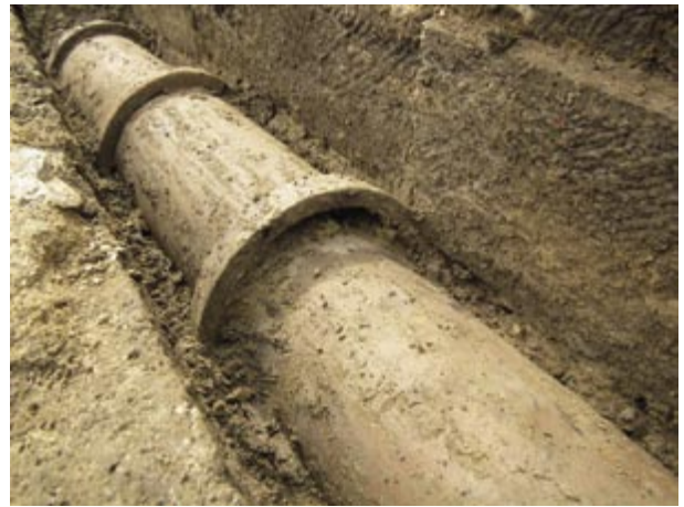
2 立会調査 導水路B-2 土管 設置状況 (北東から)
