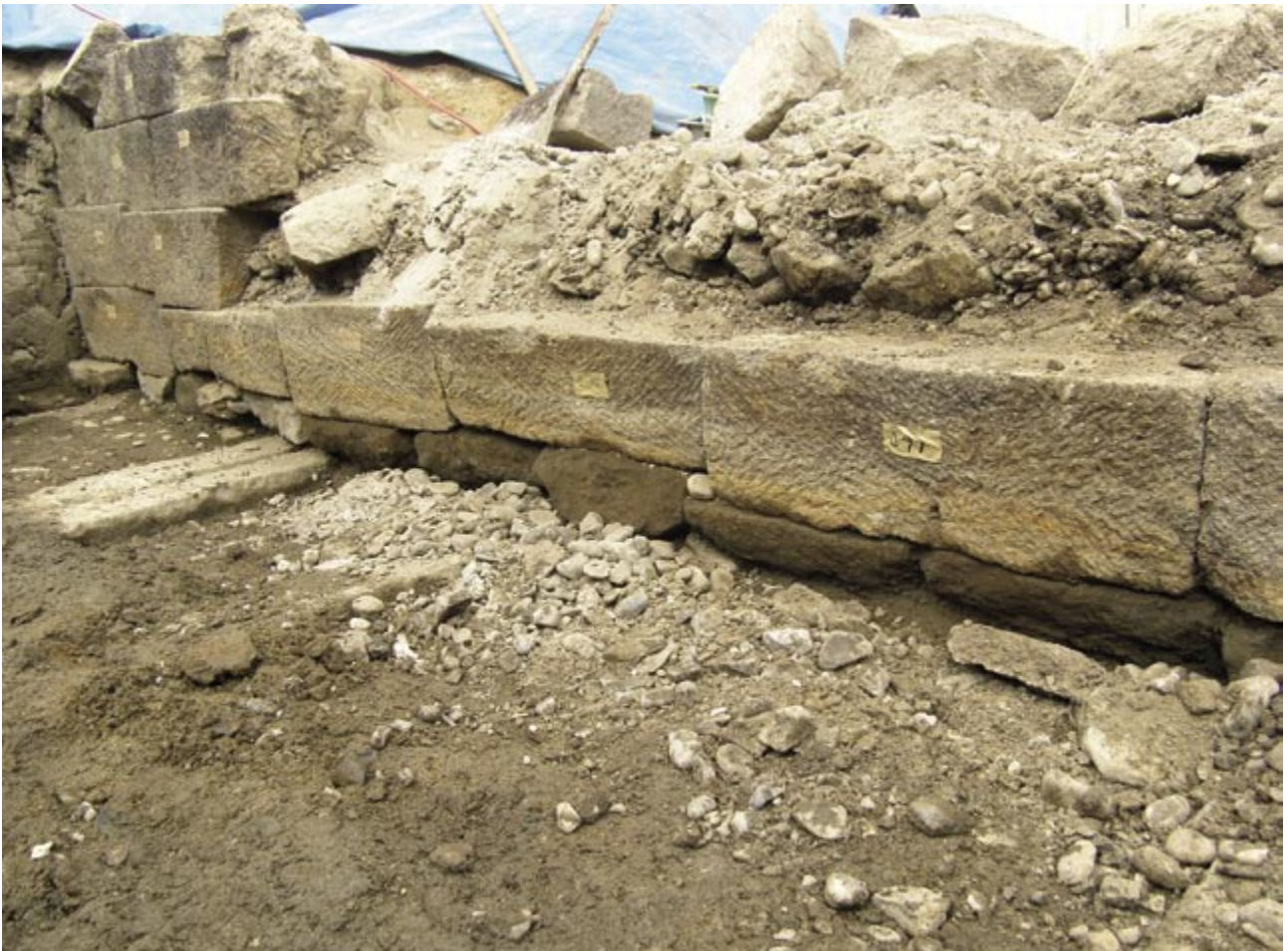
1 A工区 導水路A 東側側石 積み上げ状況 (南西から)
