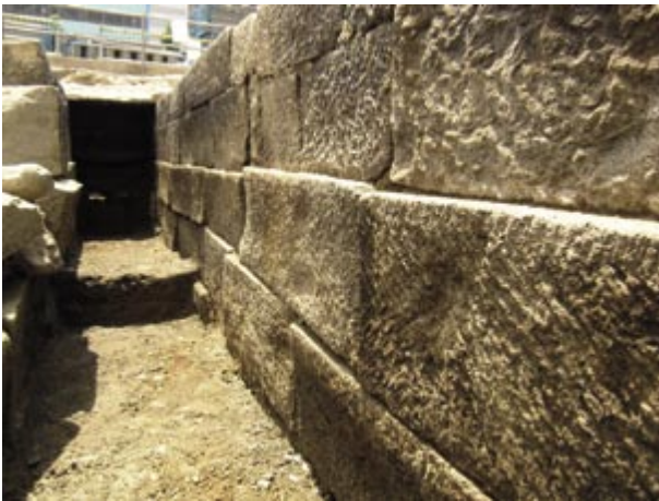
2 A工区 導水路A南半 内部 (北東から)
