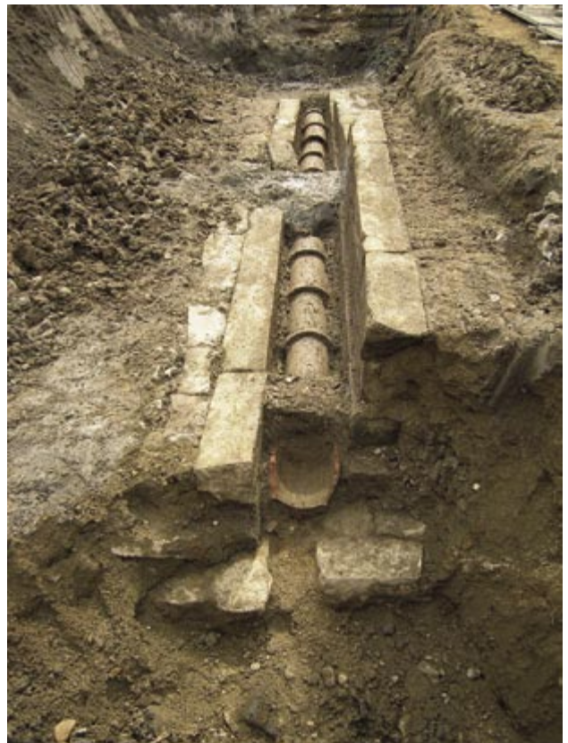
4 立会調査 導水路B-2 全景 (北から)
