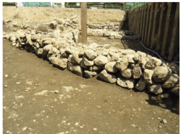
5 A工区 石垣4 背部構造 (西から)
