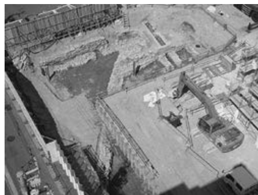
写真1 A工区 調査状況
