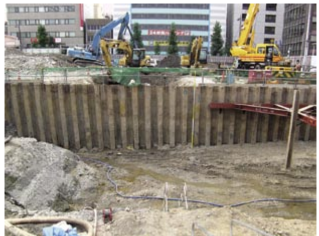
4 A工区 工事掘削後のIV層（北から）
