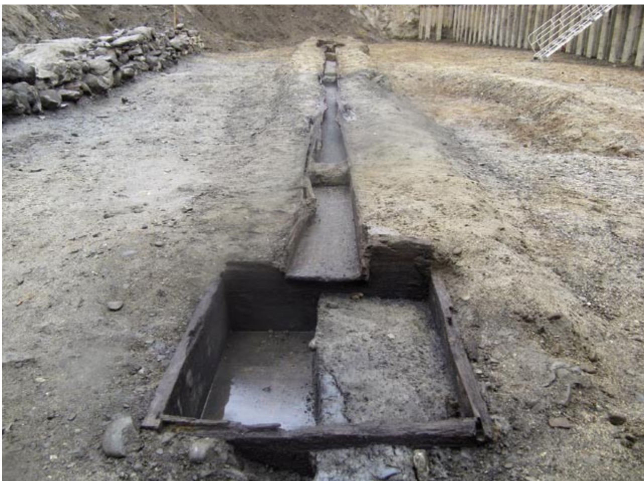
2 B工区 木樁・箱柵 設置状況（北から）
