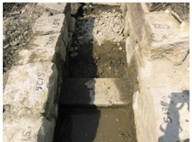
8 A工区 導水路A 南端 底部部の石材 (南から)
