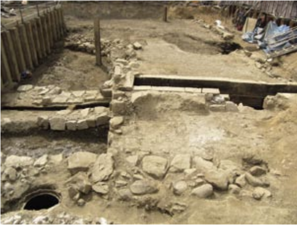
1 A工区 整地土1と導水施設 (東から)
