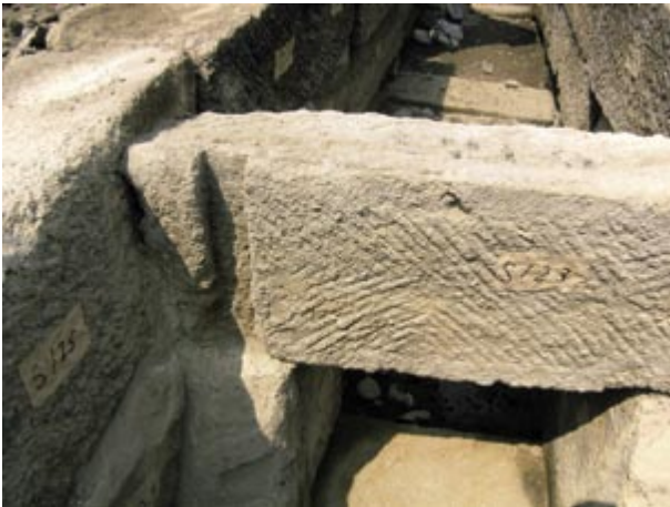
5 A工区 導水路A 南端 石材積み上げ状況 (南から)
