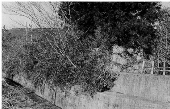
隅槽跡 (平成10年撮影)
