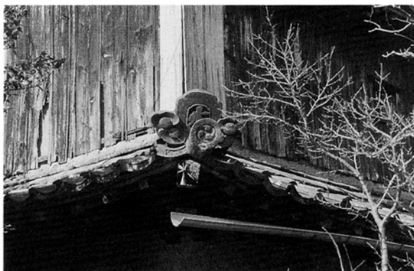
移築後の隅槽の隅巴瓦 (平成10年撮影)
