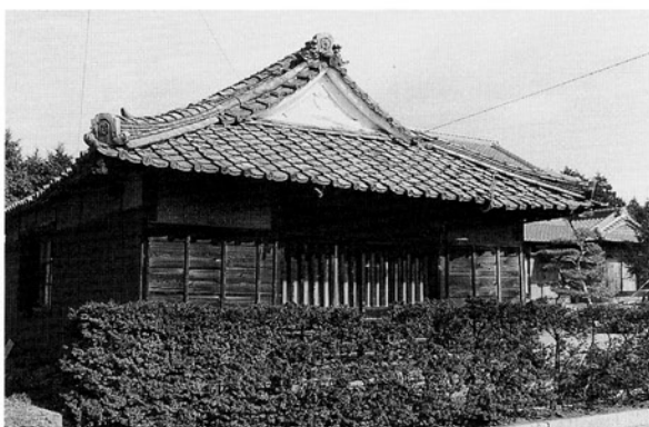
移築後の馬屋 (平成10年撮影)
