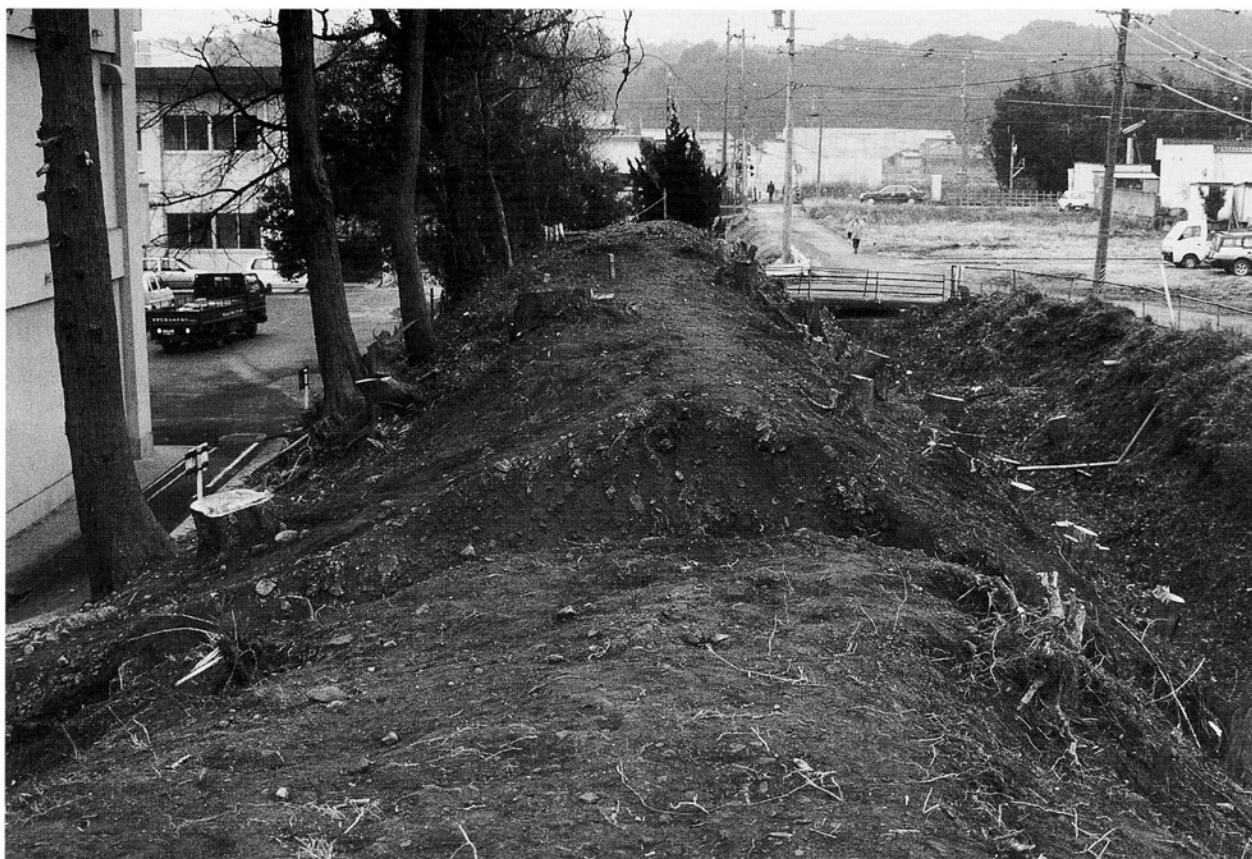
土塁（南北方向部分・北から）
