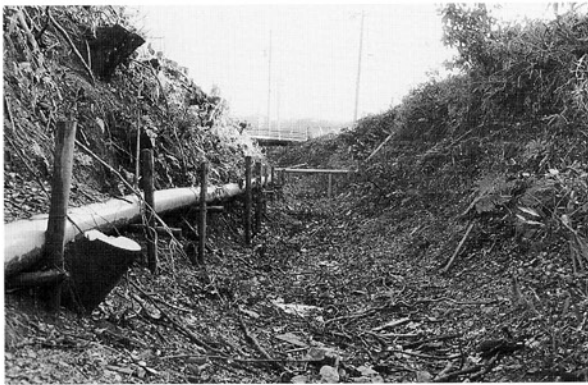
調査前 堀（南北方向部分・北から）
