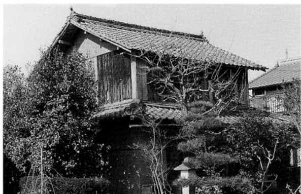
移築後の隅槽 (平成10年撮影)
