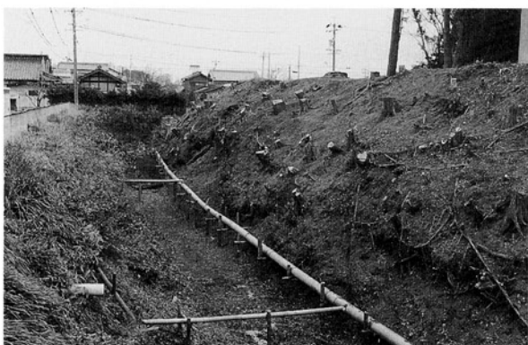
堀および土塁（南北方向部分・南から）
