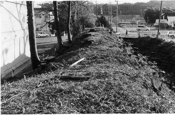
調査前 土塁（南北方向部分・北から）
