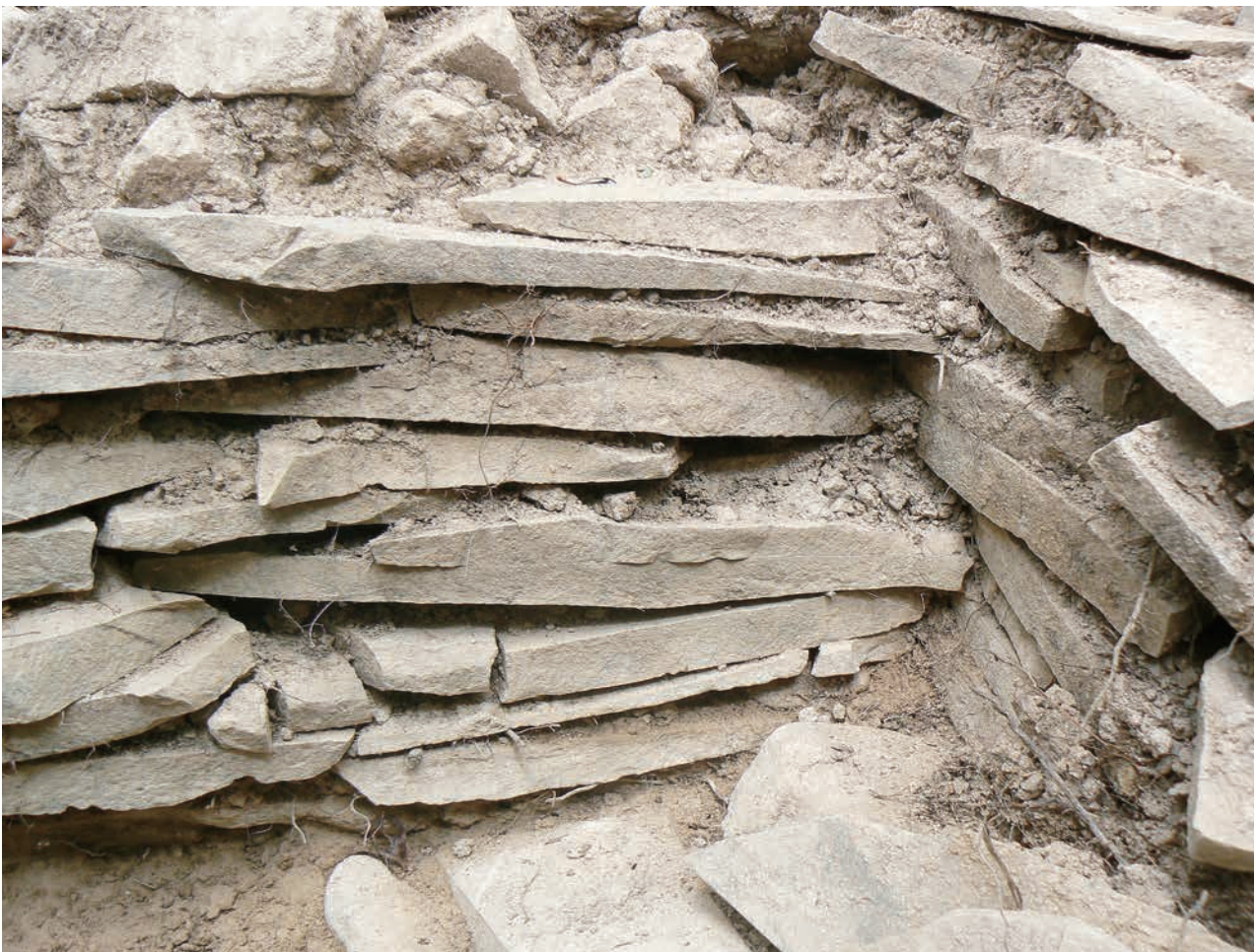
9トレンチ1段目 くびれ部拡大（西から）
