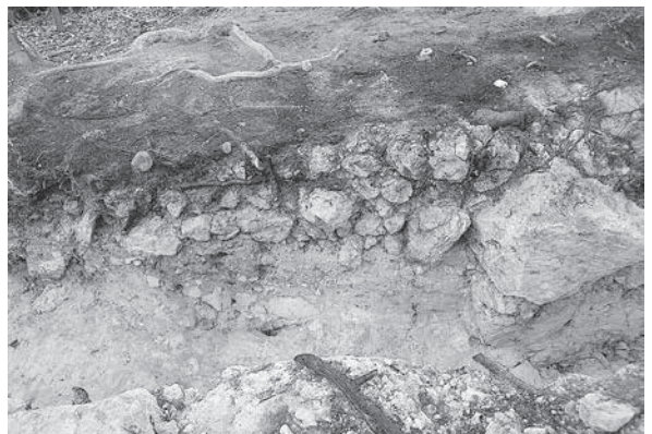
写真3-58 4トレンチ西壁 墳丘盛土 東から (6次)
