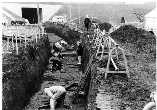
写真5 B区 遺構面掘下げ
