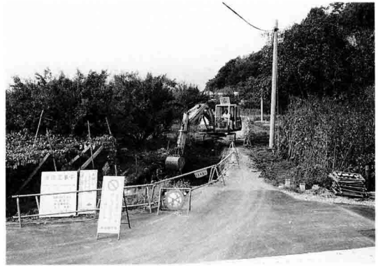
写真2 A区重機による表土剥ぎ
