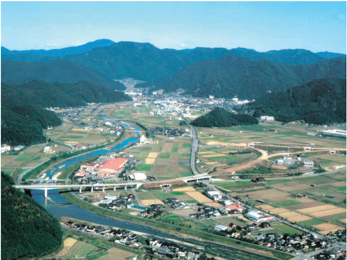
加都遺跡全景（南から）
