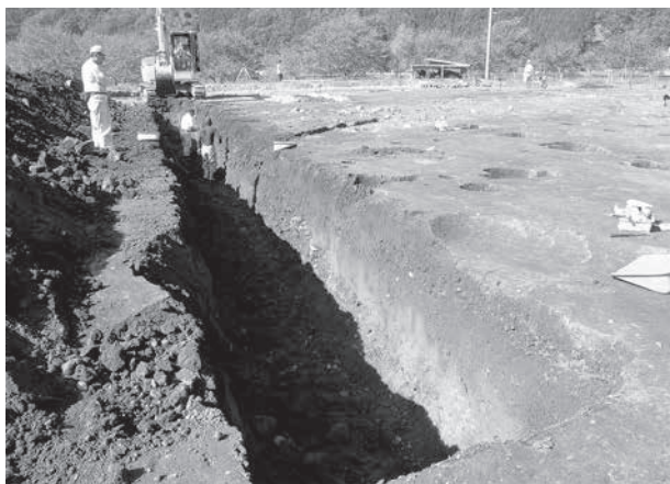
断ち割り断面 (東から)
