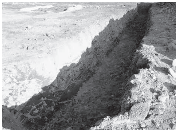
断ち割り断面 (南西から)
