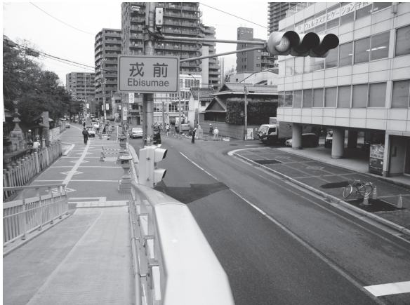
①調査地全景（南から）
