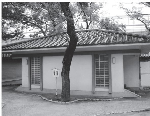
第2図 昭和54年度調査区・公衆便所（北から）
