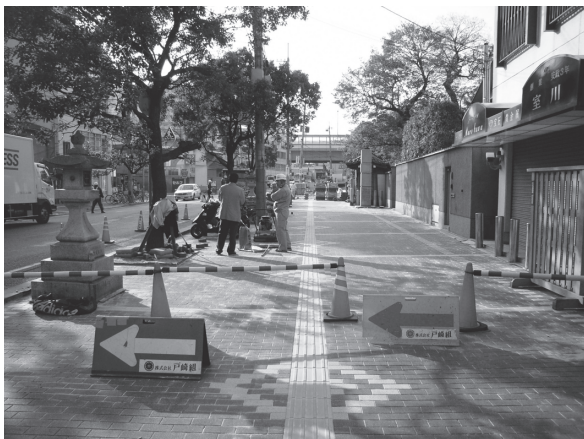
⑦西側調査区全景（北から）
