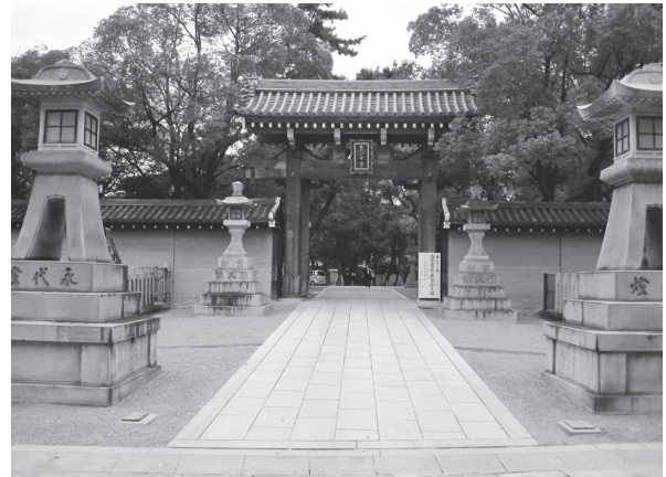
④南門（南から）
