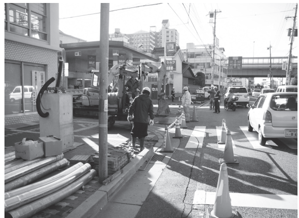
⑧T8南街灯付近（北から）
