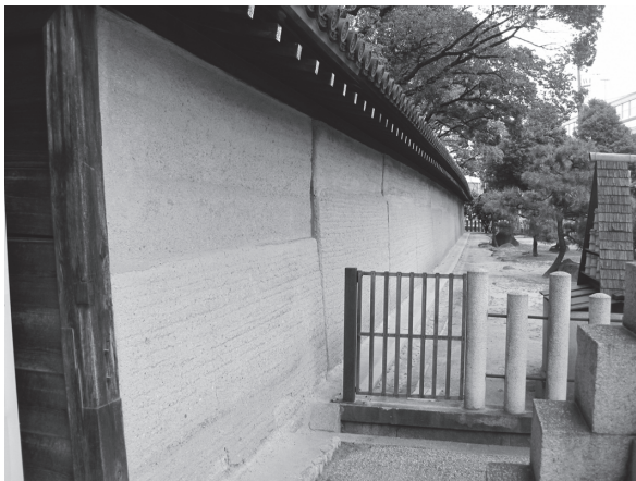
⑤東練堀・南門東側（南から）
