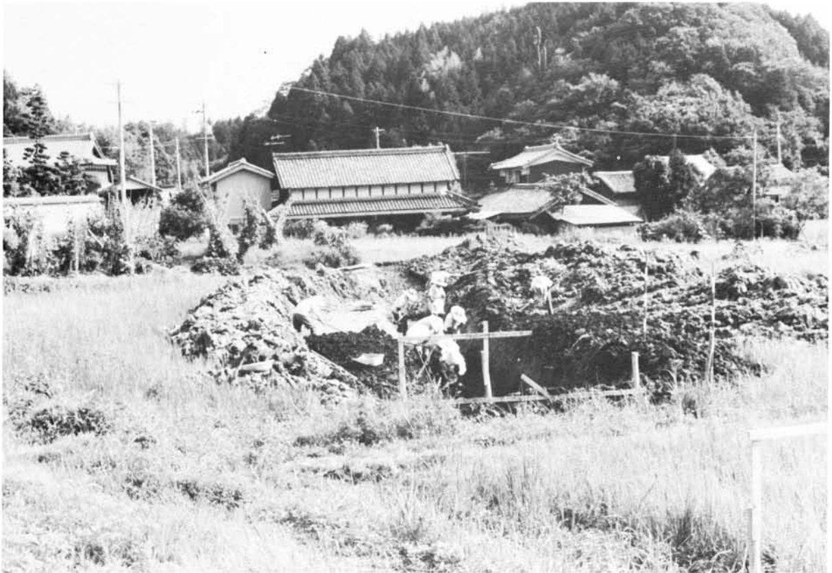
調査風景（北から）
