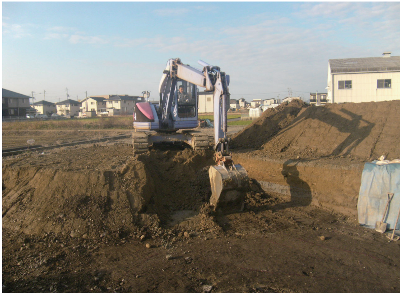
写真1 重機掘削の様子(北東から)
