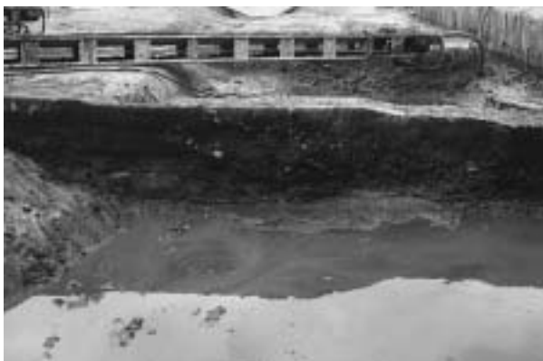
4 SR01断面④ (北から)
