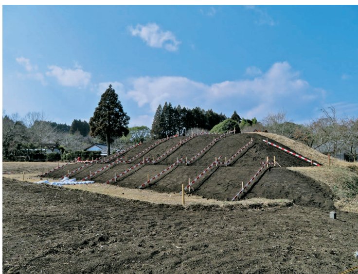
写真12 171号墳の工事状況 (南東から)
