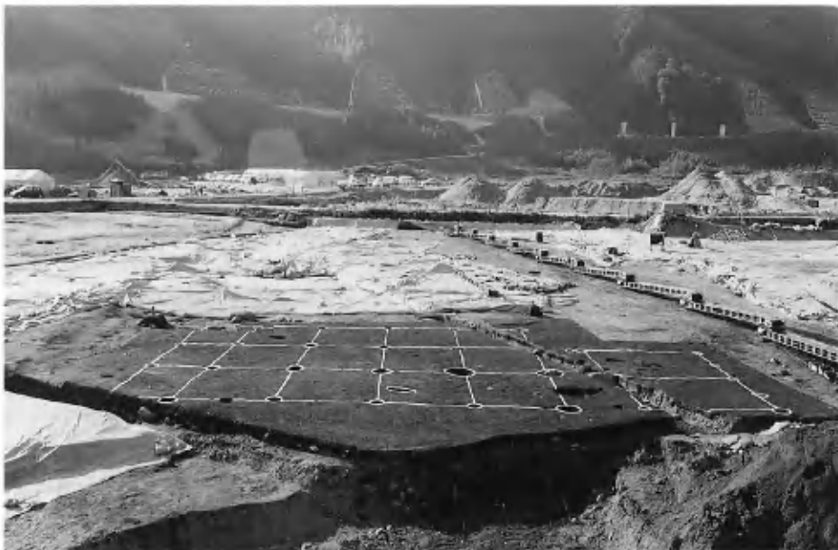
2 掘立柱建物142 ・143 (南東から)
