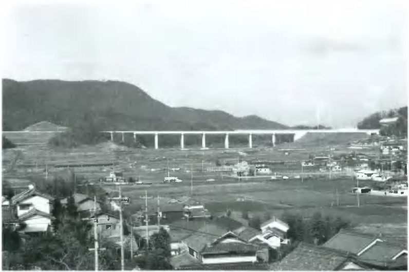
2. 調査後遠景（東から）
