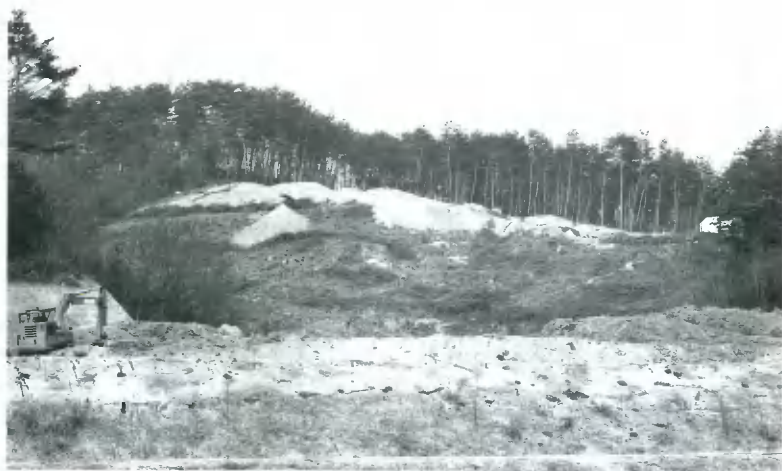
2. 表土除去後の遠景（東から）
