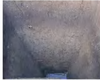
写真12 T26北壁（南から）
