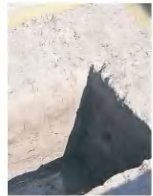
写真47 T58北壁 (南西から)
