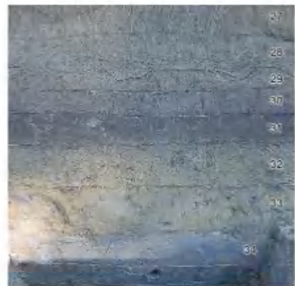
写真50 T61北壁（南から）
