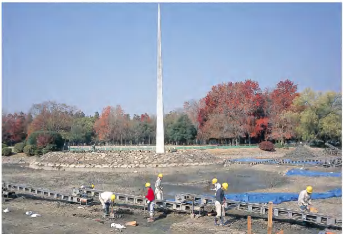
2 南池地点全景 2002年11月（南から）
