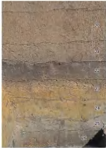
写真23 T37北壁（南から）
