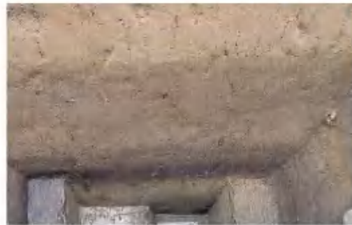
写真13 T27北壁（南から）
