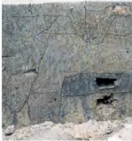
写真2 T16南西壁（北東から）
