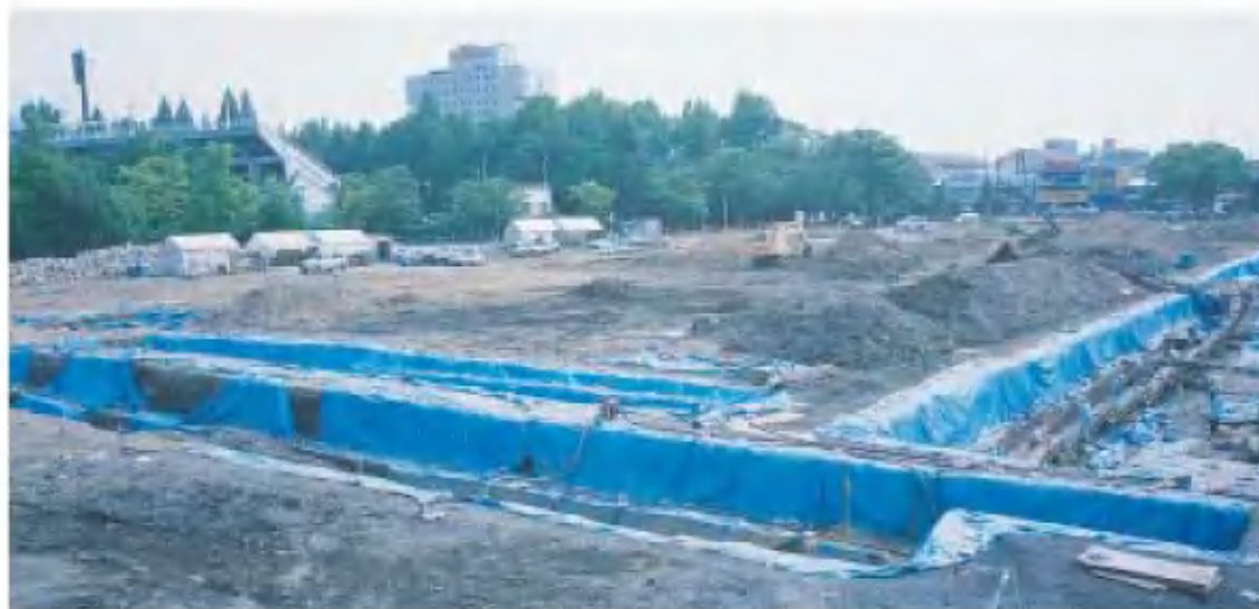
2 調査状況（南西から）
