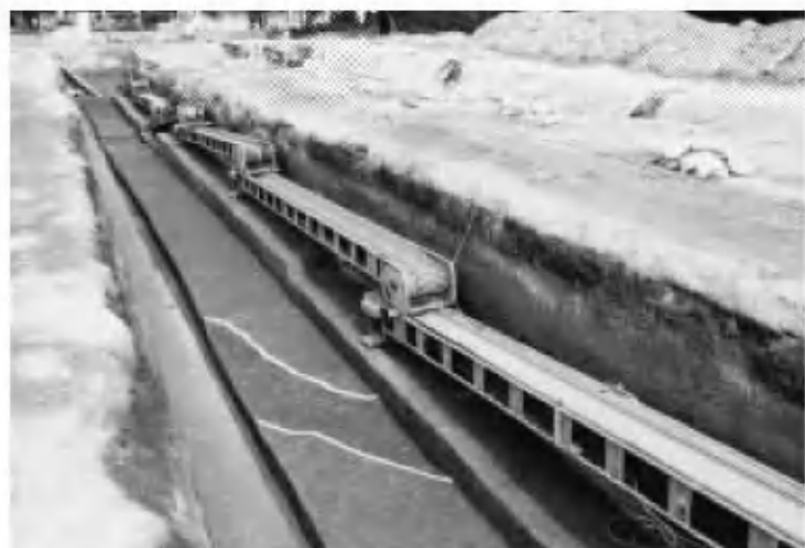
4 F区 完掘状況 (西から)
