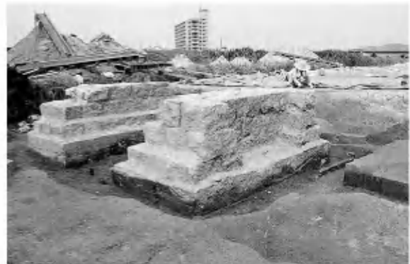
写真2 軽便鉄道橋脚（東から）
