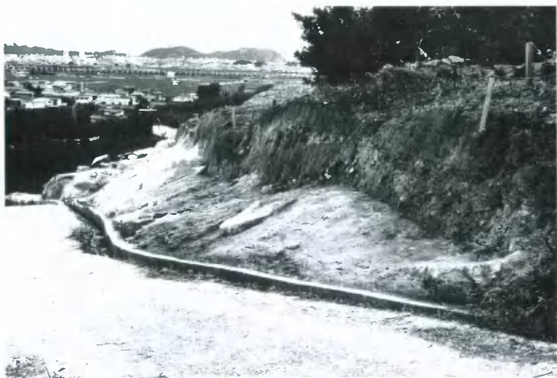
2. 工事用道路建設に伴う追加発掘調査区（Bライン東端；北から）
