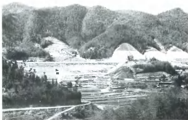
2. 自動車道開通後の遺跡の遠景
