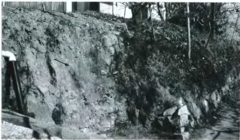
2. 遺跡付近に露出する窠体断面 (北西から)
