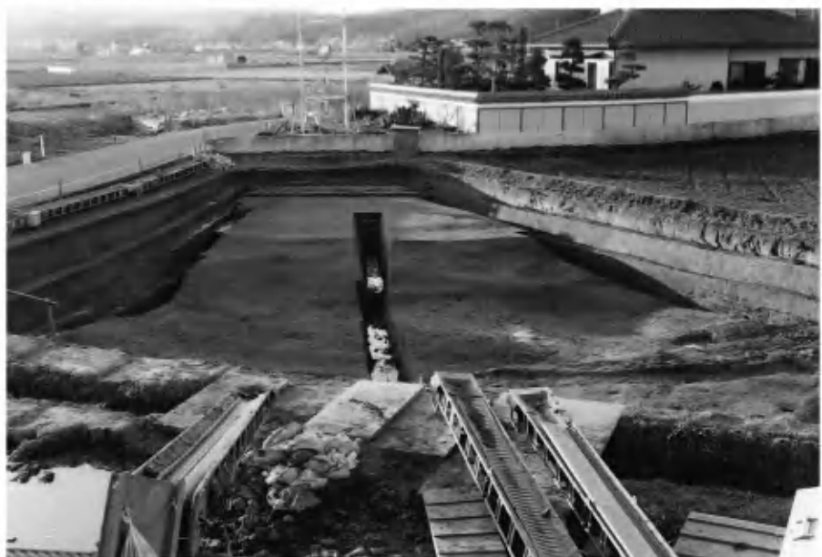
3 河道2 (南東から)
