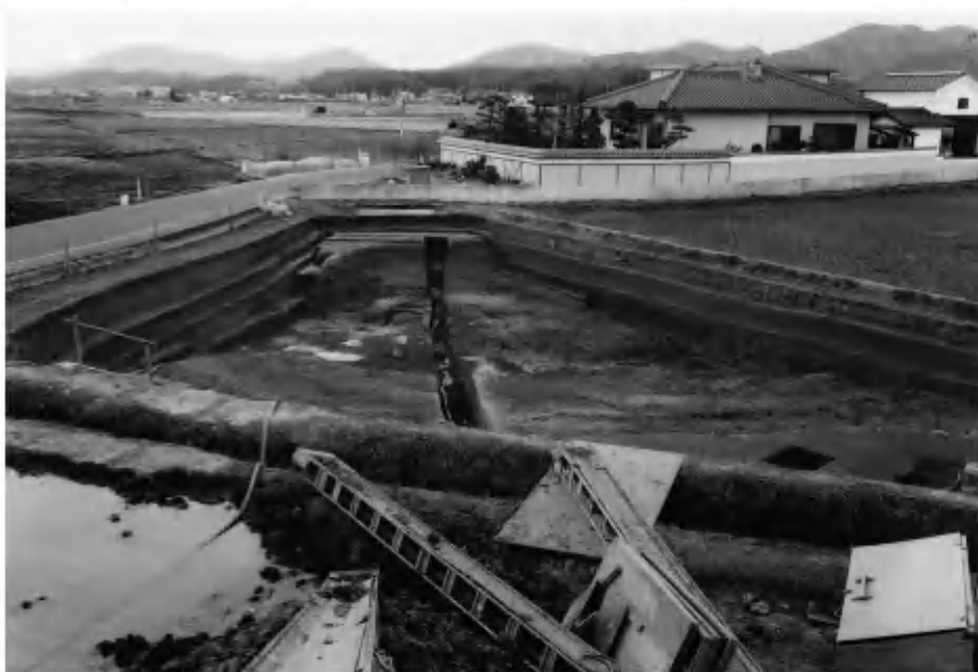
2 河道 2 (南東から)
