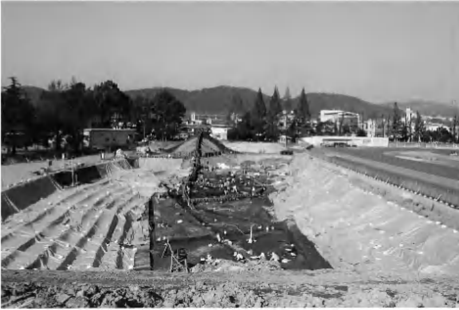
1 河道1 全景 (南から)
