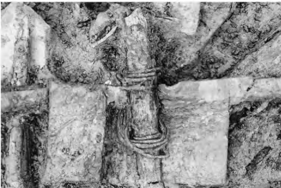
3 河道1北岸 構造材6 緊縛状況 (南から)
