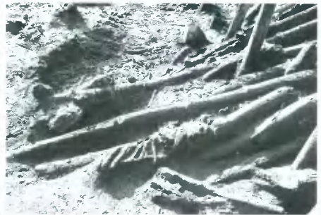
3 復旧施設2 しがらみ (東から)
