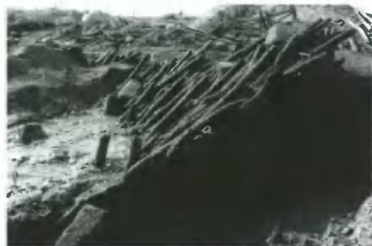
第263図 堤防復旧施設2 (東から)
