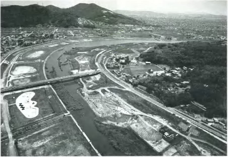
1 橋梁2 空中写真（北西から）
