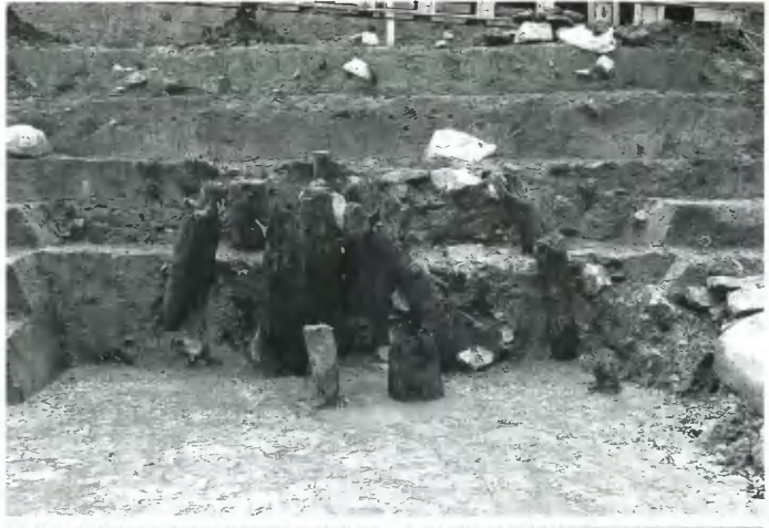
1 橋梁1南端 (北から)
