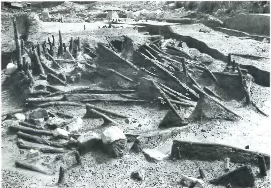
2 堤防復旧部 洪水砂（洪水2）除去後（西から）
