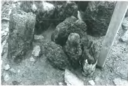
3 橋梁2 橋脚り打ち込まれた杭
