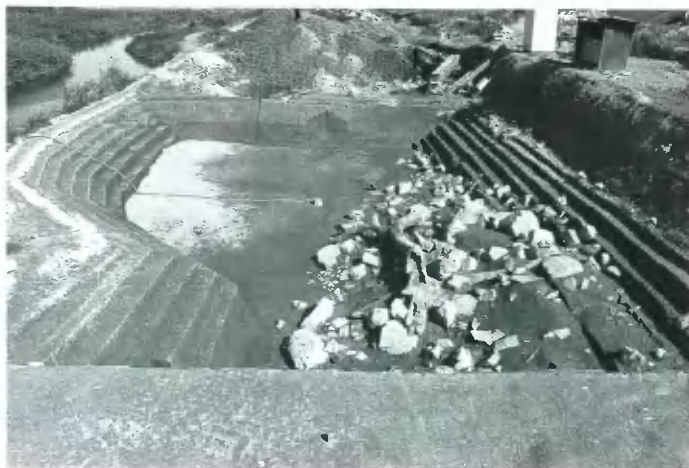
1 1区河道1 (西から)
