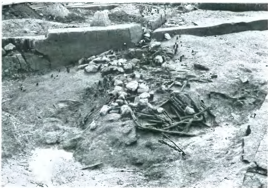
2 堤防先端部 盛土内部の状況 (北東から)
