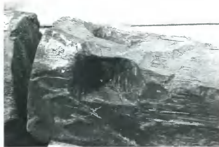
4 橋梁2 橋脚先端部の筏穴
