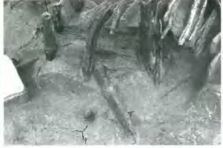
2 堤防中央部 盛土下の倒れ杭 (南西から)
