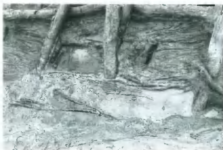
3 復旧施設4 しがらみ(南から)
