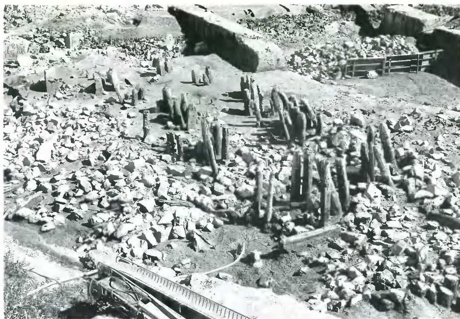
1 橋梁2 埋め土と河道堆積を除去した状況 (I期の姿にちかい) (北西から) 周辺の礫は埋立1
