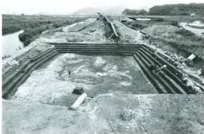
2 1区河道1 (西から)
