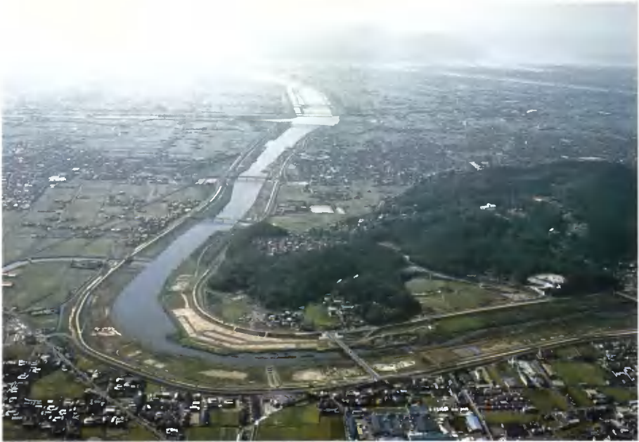
1 調査地遠景（北から）
