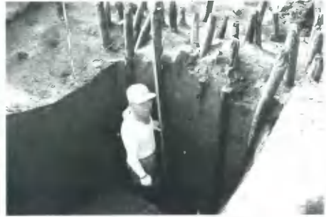
4 堤防中央部 縦杭 (東から)
