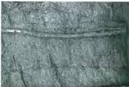
4 堤防中央部 盛土内の編み物
