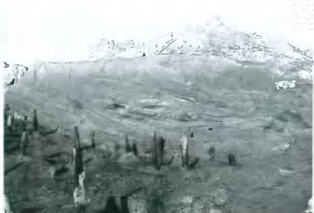
8 堤防復旧部洪水砂堆積状況(南東から)
