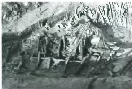
2 復旧施設4 草本類除去後の状況(南から)
