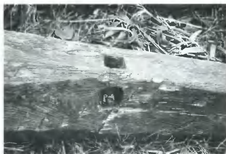
3 橋梁2 橋脚先端部の筏穴
