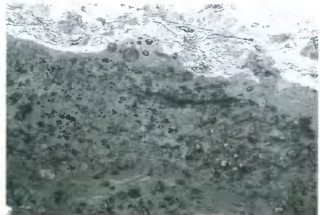
3 護岸2 断面B-B' (北西から)
