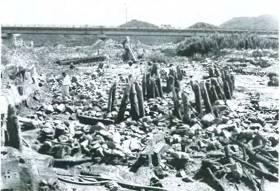
5 橋梁2 埋め土と河道堆積を除去した状況(I期の姿にちかい)(西から)周辺の礫は埋立1
