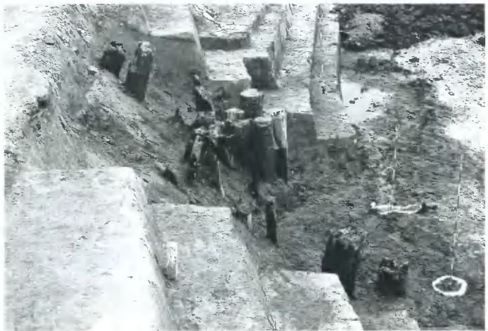
3 橋梁1北端 (西から)
