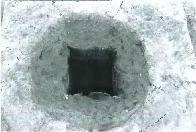
2 井戸315石組み 除去後 (北から)
