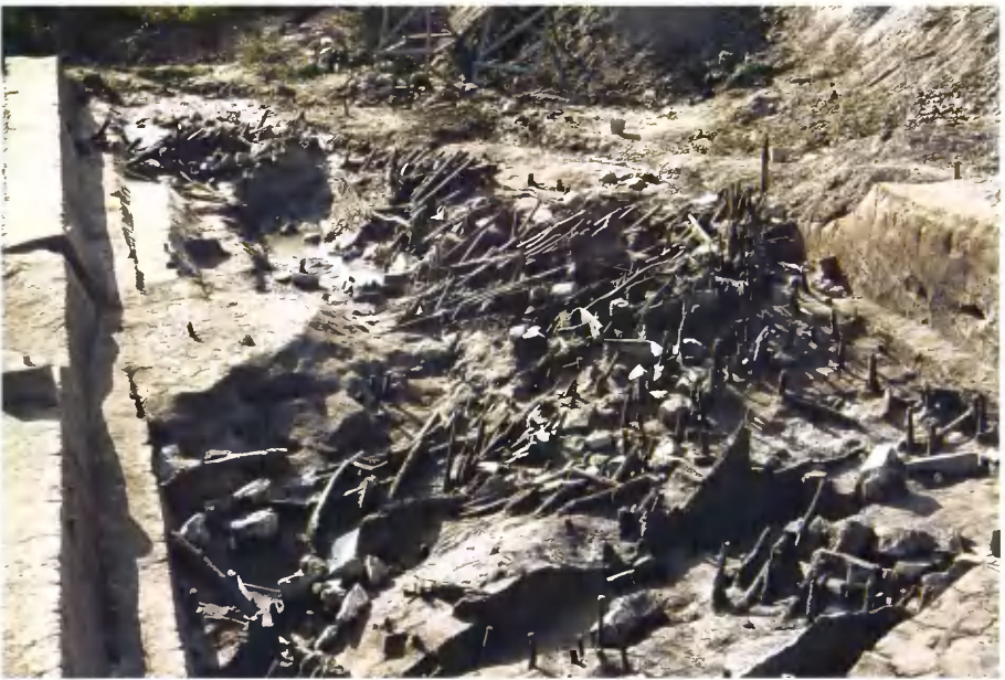
2 堤防復旧部（北東から）
