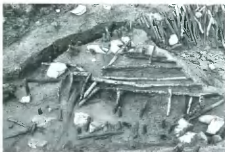
5 復旧施設4 基底部の木組み(南から)
