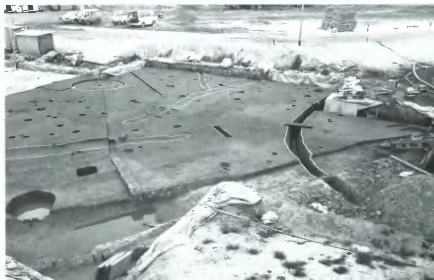
3. 溝50~53 (CH2区; 南から)
