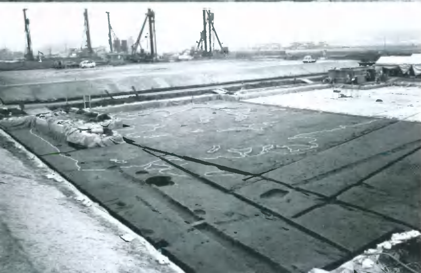
3 粘土採掘跡 (KO2区：東から)
