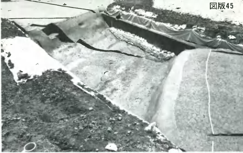
1. 河道4 (CH4区;北から)
