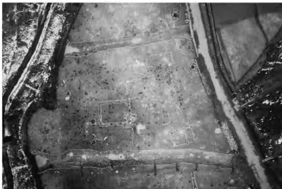
2 調査区中央全景 (上空から)
