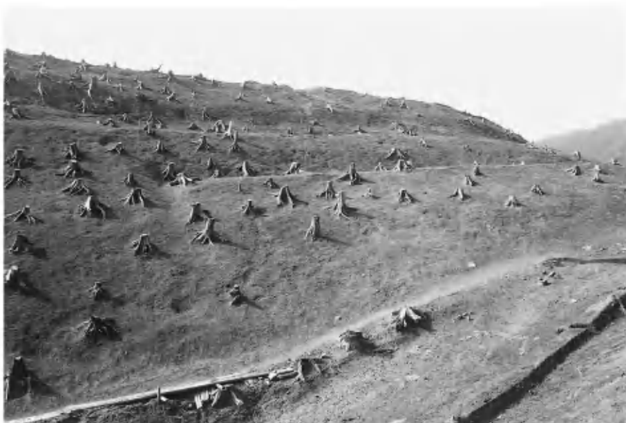
1 切岸・土塁 2、3 (北東から)
