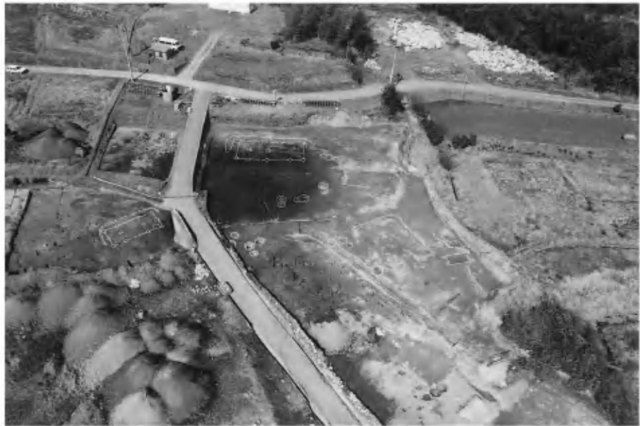
2 調査区全景 (南東上空から)
