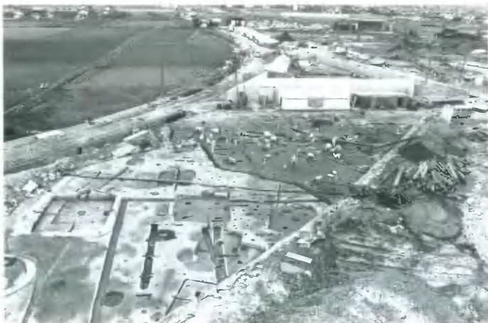
1. 作業風景 (西から)
