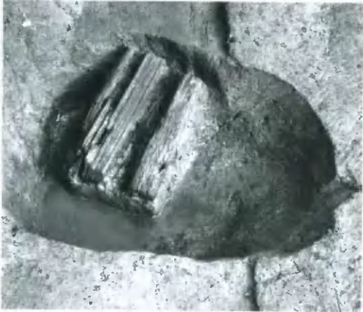
2. 建物12・同柱穴の礎盤 (西から)
