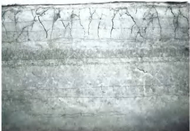
3. 39C区土層断面 (南西から)
