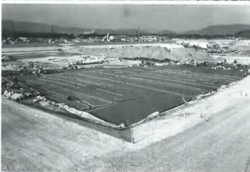
2. 素掘溝群5・6 (NC3区、南西から)
