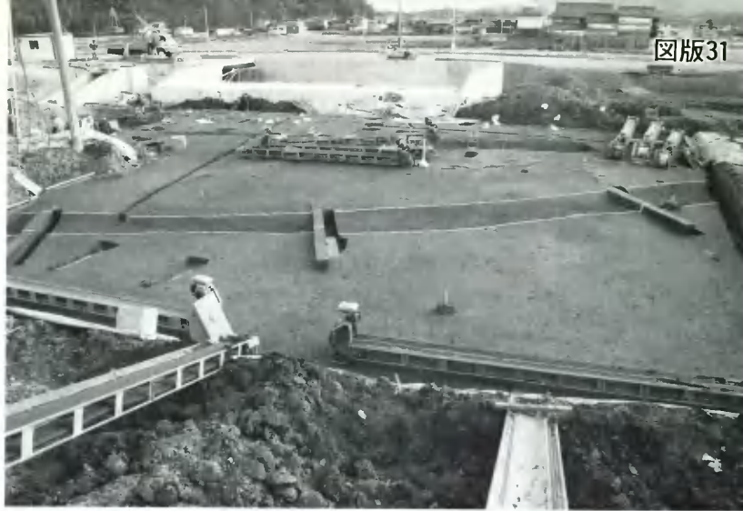
1. 溝161 (NC1区、北西から)
