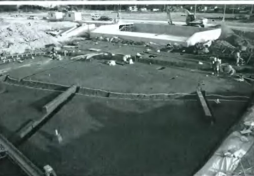
2. 溝157 (NC1区、北西から)
