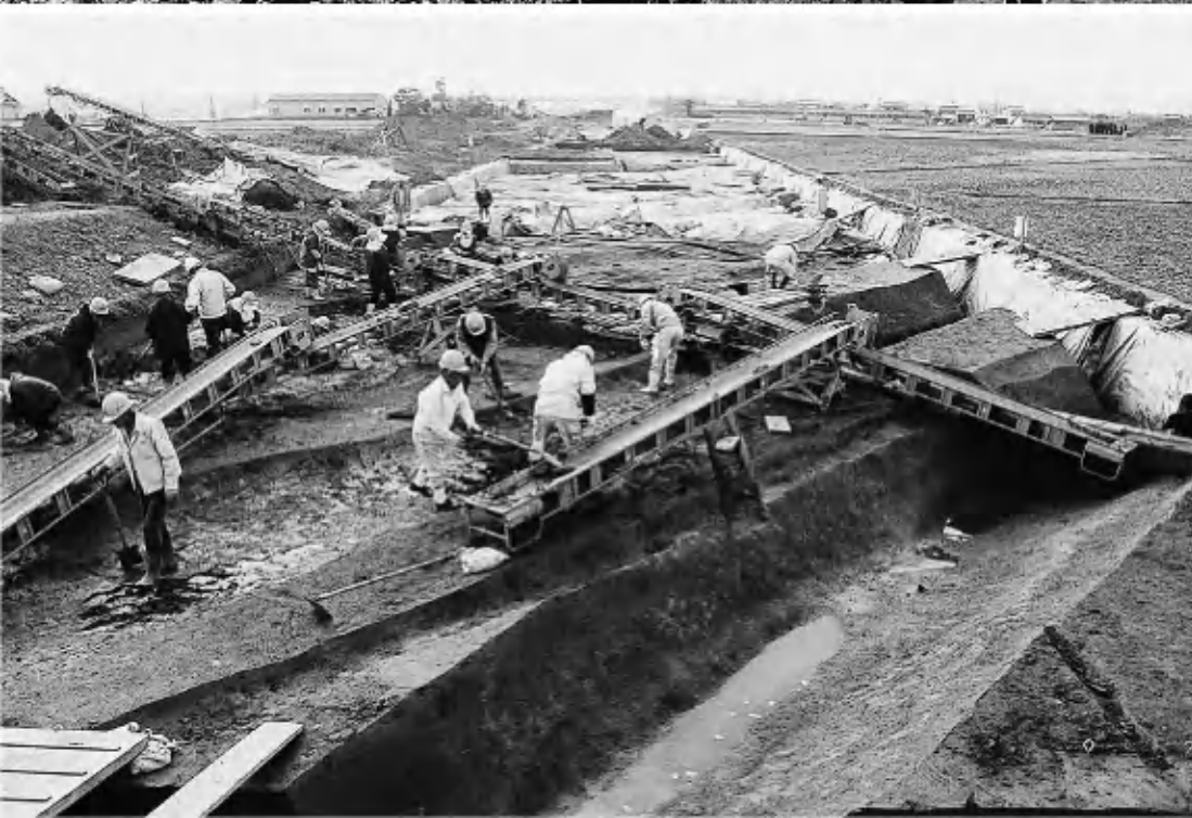
3 仏生田遺跡1区 溝4発掘作業風景 (北から)
