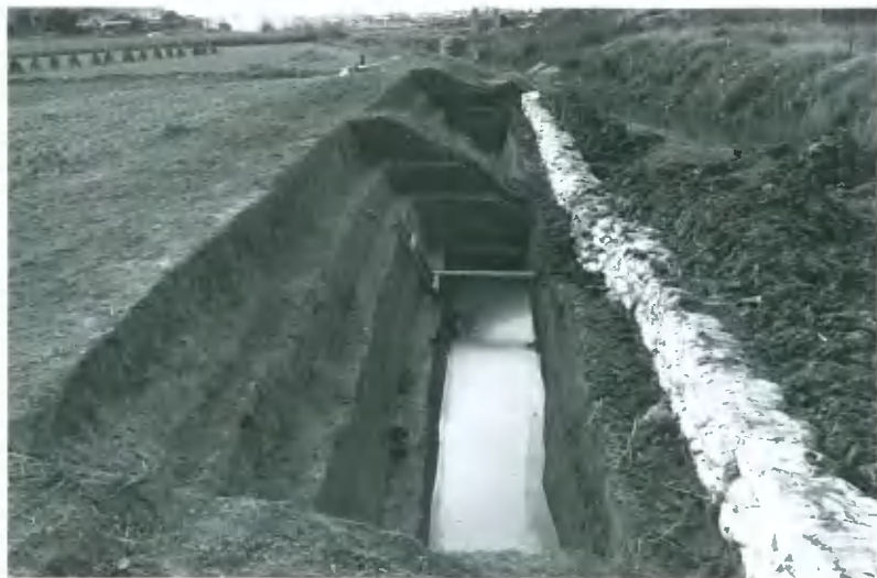
1. 流田・開ノ山下 215・216-Q~W<右岸用水> (東から)
