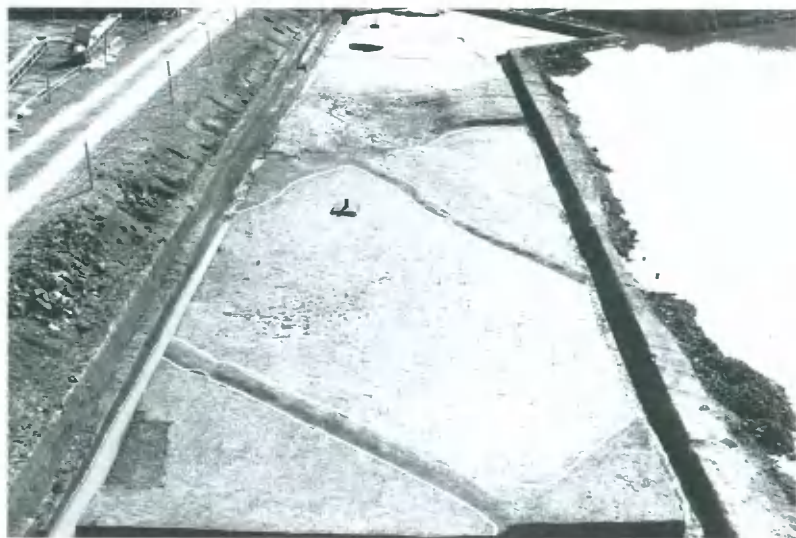
1. 足洗 弥生時代後期水田<219・210-BB区> (北から)
