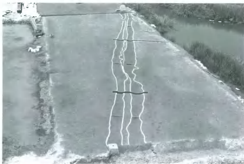
2. 足洗 溝 154・155 (東から)
