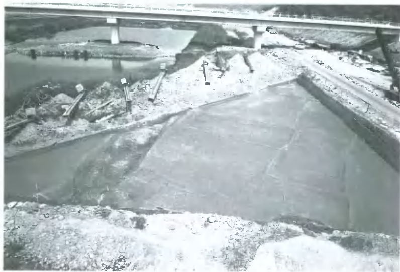
2. 足洗 弥生時代後期水田<211・212-CC・DD区> (西から)
