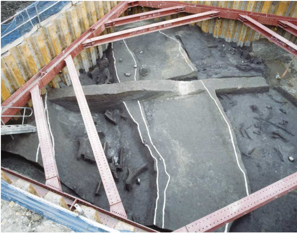
写真2-2-38 01Ad区2面全景（西より）
