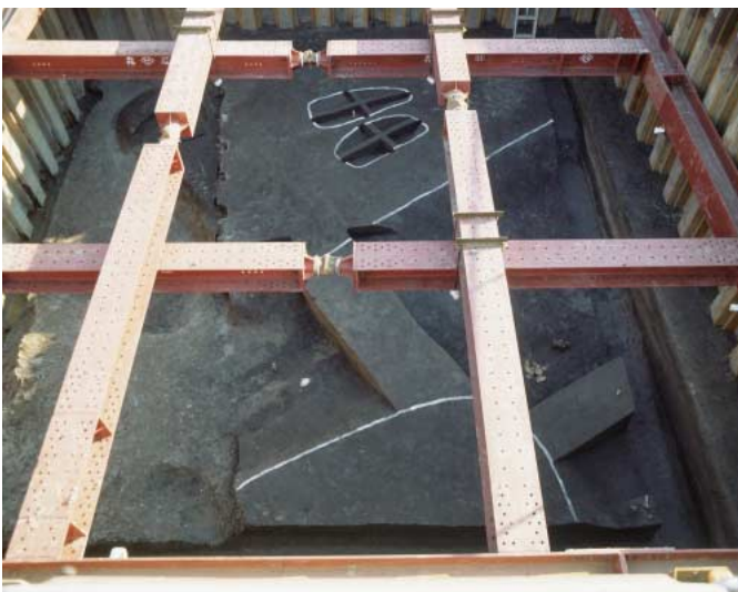
写真2-2-134 99Cf区1面全景（北より）
