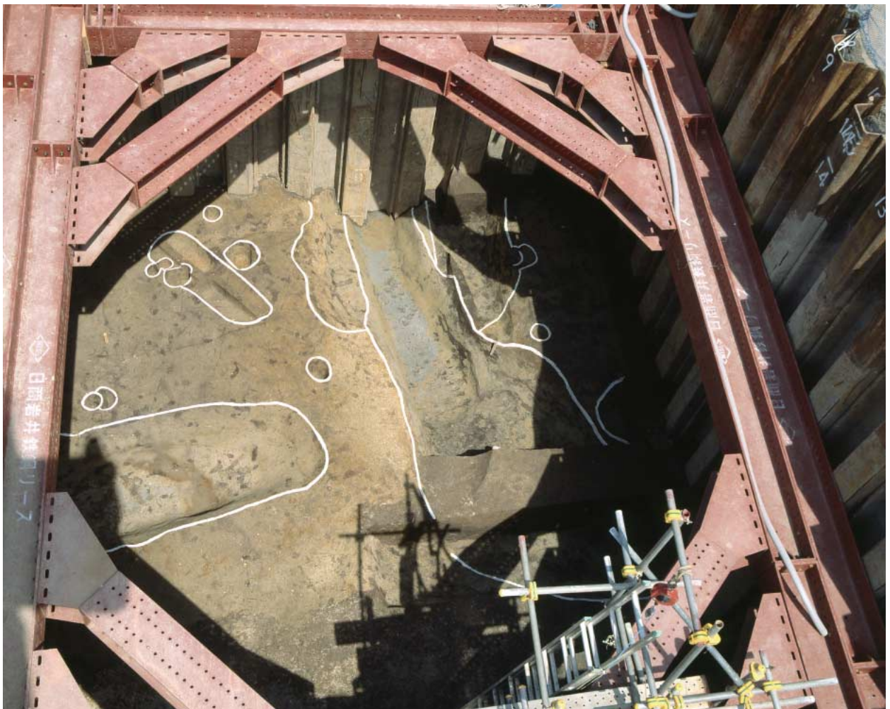
写真2-2-101 02Bj区2面全景(西より)
