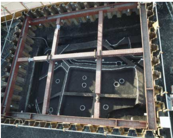
写真2-2-7 99Ac区1面 全景 (北東より)
