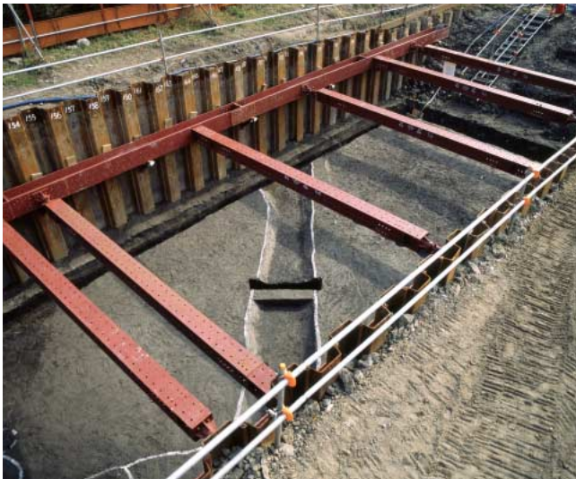
写真2-2-138 99Ce区SD02(南東より)
