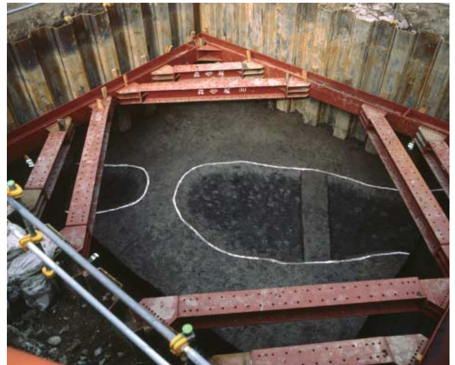
写真2-2-141 98Ca区SD01・SD02(南東より)
