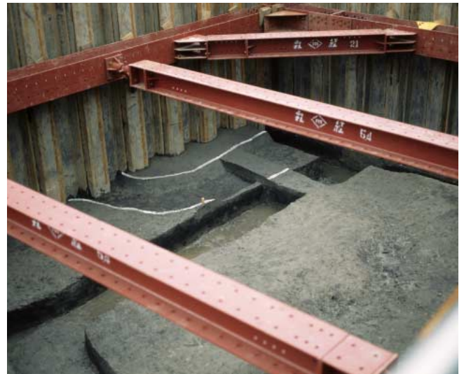
写真2-2-139 99Ce区SD03(南東より)
