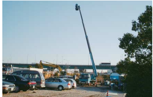
写真1-2-6 高所作業車による写真撮影
