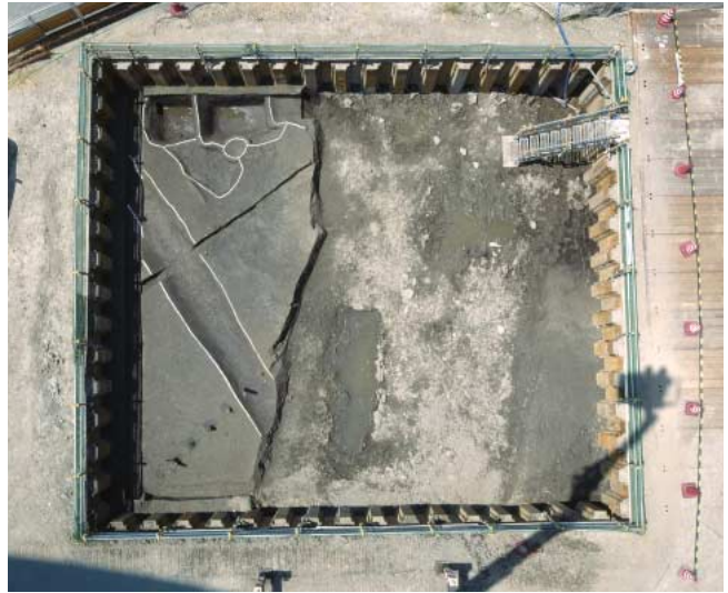
写真2-3-1 03Ca区2面全景(北より)
