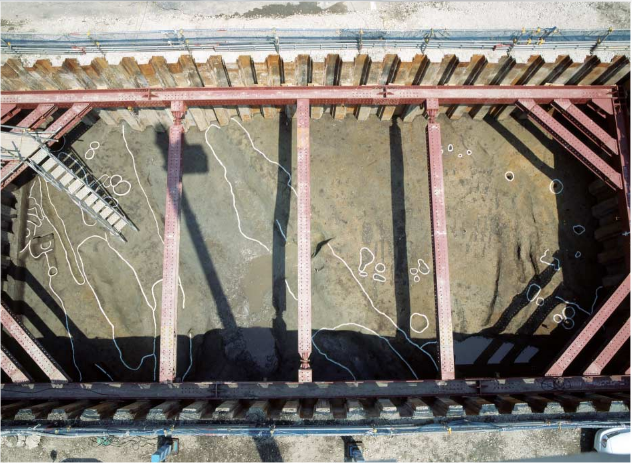
写真2-2-97 02Bh区2面全景（西より、写真下側がSZ207）
