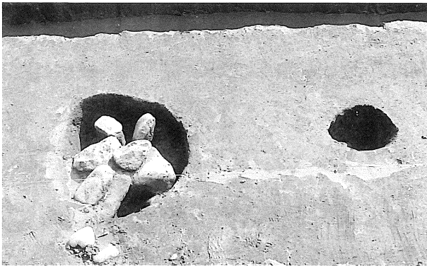
3 同上 SP02/SP03掘削状況
