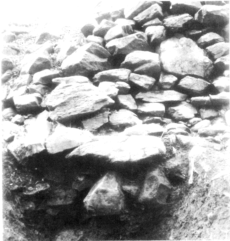
第9図 石塁基礎部分
